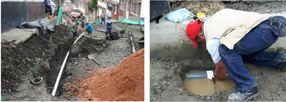
Fotografía 9 Instalación de tuberías potables
