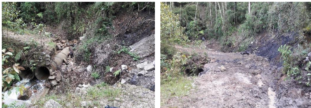
Fotografía 2 Rehabilitación paso sobre la quebrada la tinajera.
