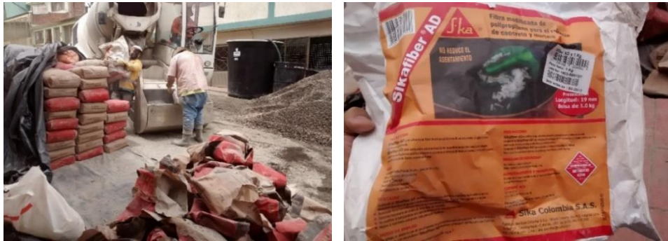
Fotografía 7 Mezcla del concreto
