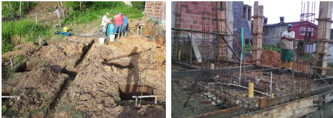
Fotografía 17 Avance de obra Nelly Bianey Acosta
