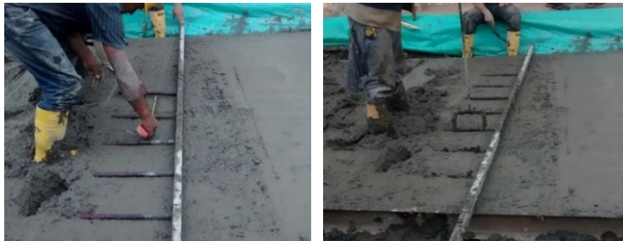
Fotografía 8 Instalación de dovelas de 7/8"
