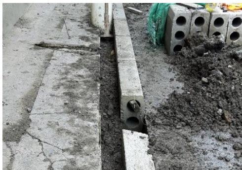
Fotografía 10 Instalacion de sardinel
