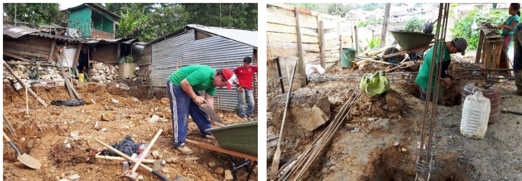
Fotografía 18 Avance de obra Luz Eulalia Alfonso
