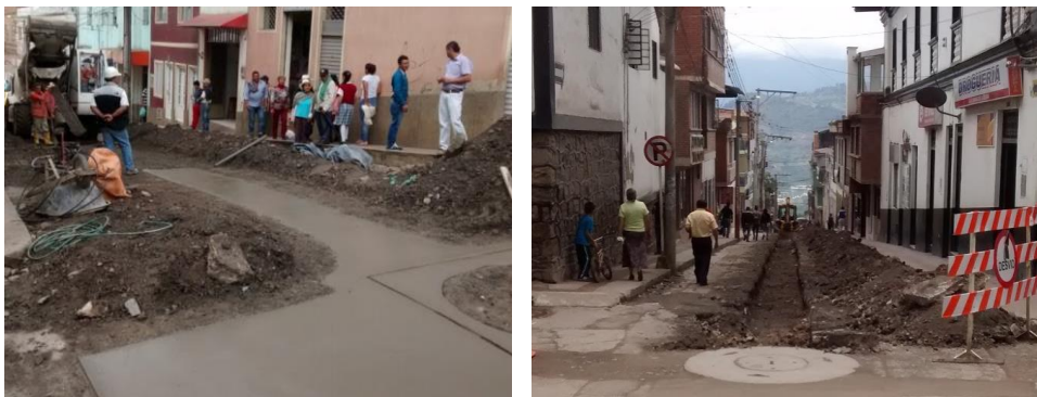
Fotografía 54 Mitigacion en concreto
