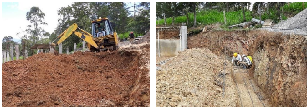
Fotografía 15 Excavacion via de acceso
