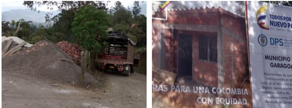
Fotografía 25 Acopio de material y valla del proyecto
