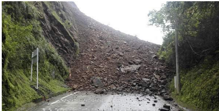
Fotografía 52 Derrumbe en la salida del túnel Pozo Azul
