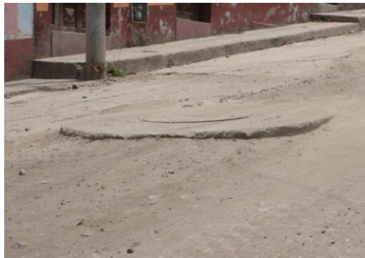
Fotografía 12 Pozo calle 13 entre carreras 8 y 9
