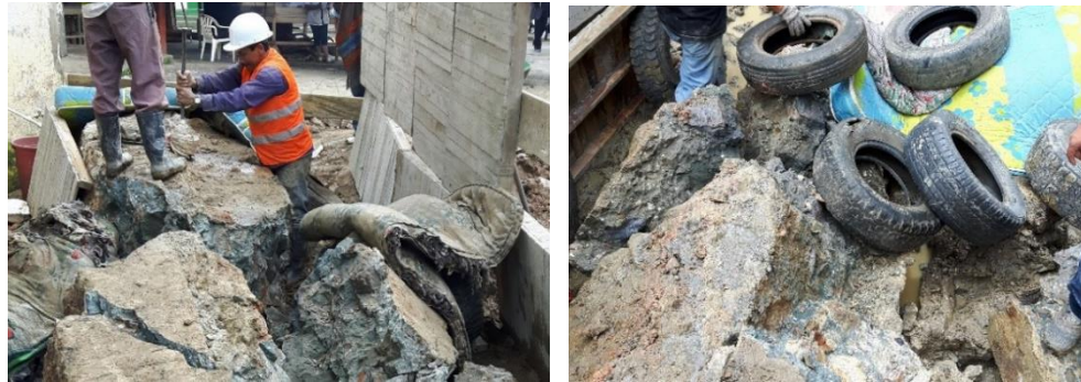
Fotografía 13 Voladura de viga
