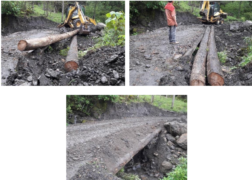
Fotografía 1 Rehabilitación puente quebrada Ubacon
