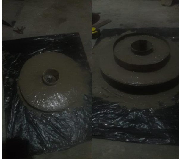
Figura 44. Construcción de la tapa del horno.
