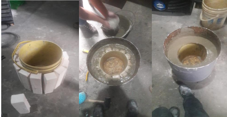
Figura 42. Construcción de las paredes Internas.
