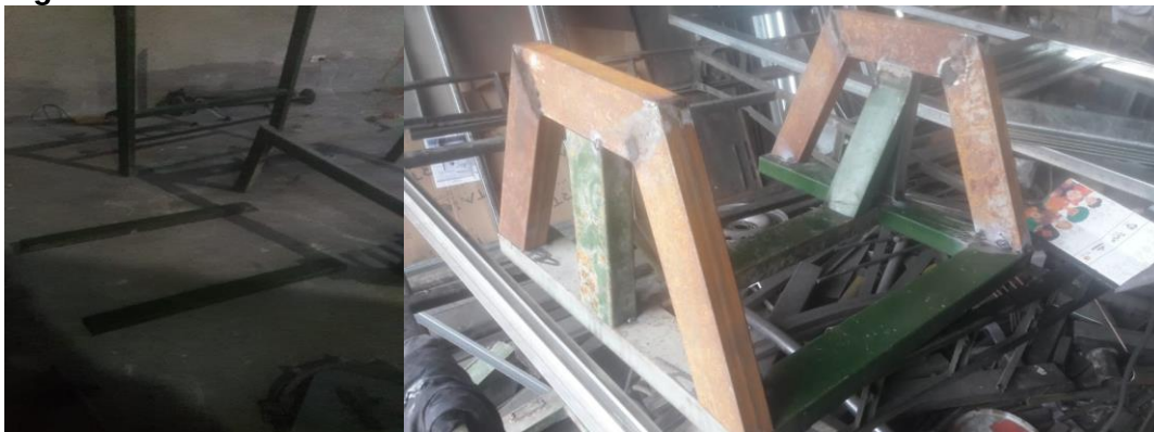
Figura 47. Construcción de estructura.
