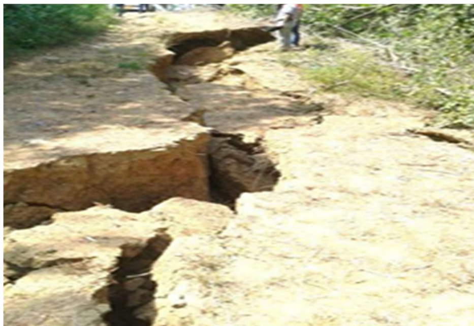
Figura 22. Primera etapa del deslizamiento en el sector de los tanques en el cerro Sierra Chiquita. Fuente: Elaboración propia.
