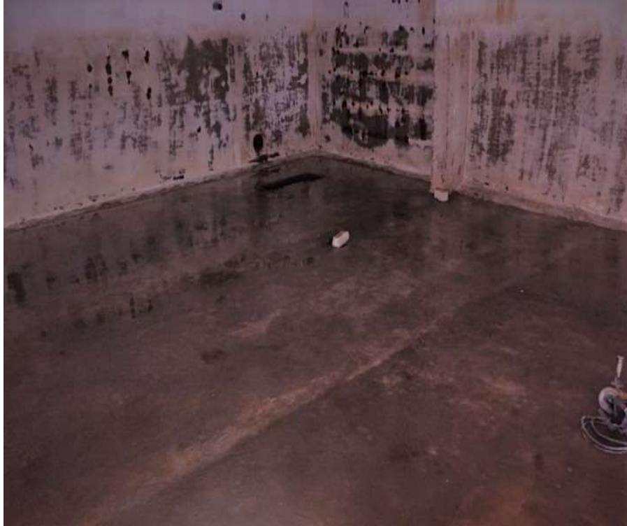
Figura 20. Se observa la losa inferior del tanque en buen estado. Fuente: Elaboración propia.
