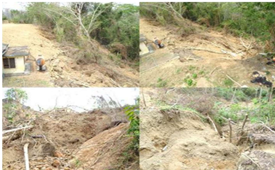
Figura 23. Deslizamiento en el sector del tanque en el cerro Sierra Chiquita. Fuente: Elaboración propia.
