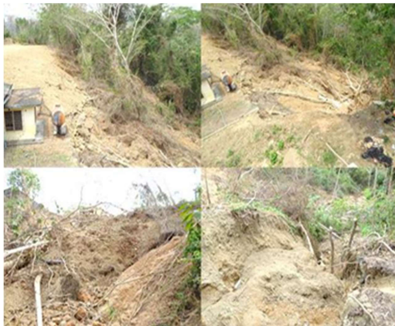
Deslizamientos que se presentaron alrededor del tanque de almacenamiento
