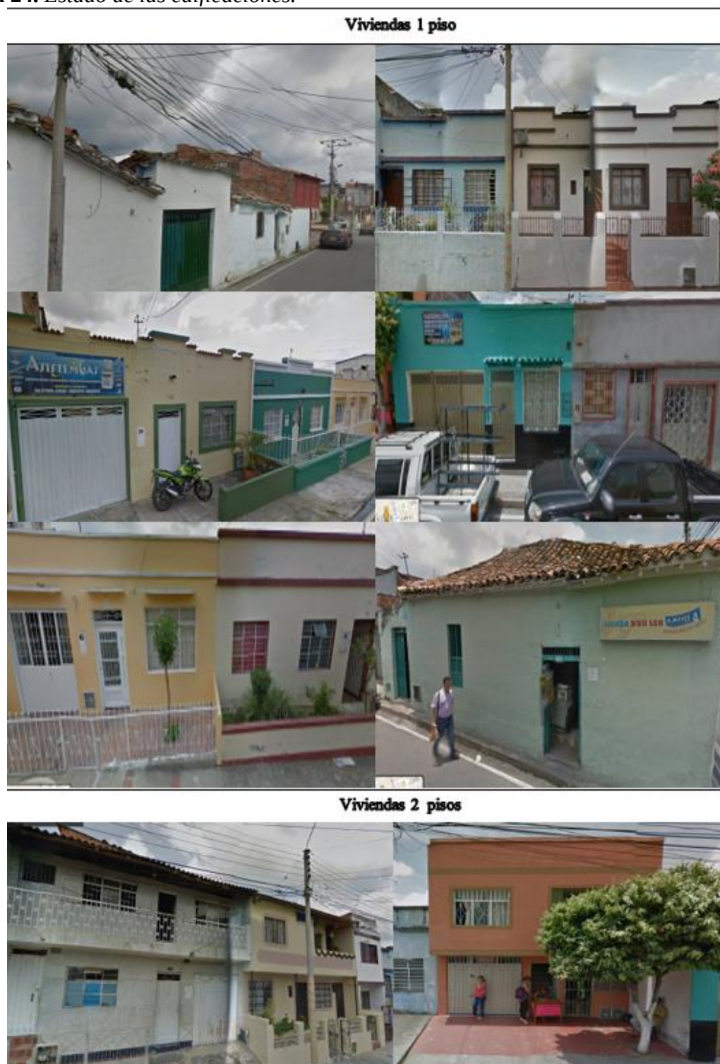
Figura 24. Estado de las edificaciones.
