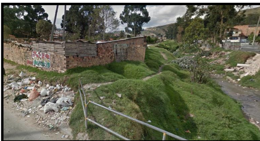
Figura 59: Evidencia de la mala ubicación de residuos cerca de las viviendas en zonas de alto riesgo.
