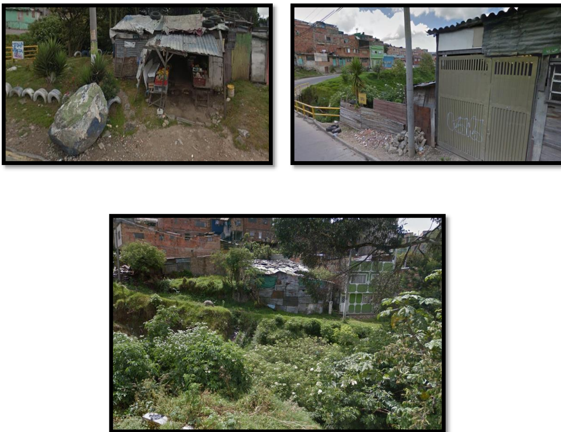
Figura 56: Evidencia de ubicación de viviendas construidas en materiales inadecuados
