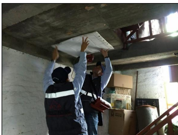
Figura 37. Ensayo de ultrasonido en placa de entrepiso en cara inferior.
