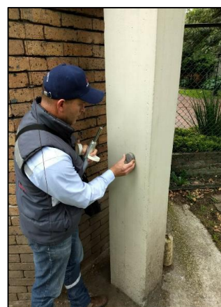
Figura 38. Ensayo con esclerómetro en columna.
