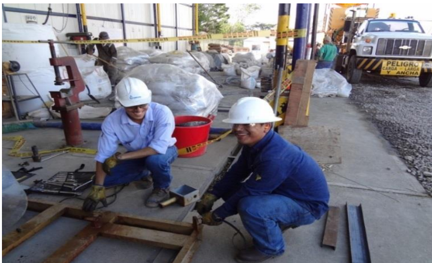
Fotografía 2 Base de operaciones Completion Services
