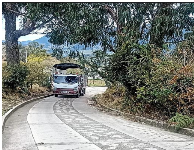
Figura 34. Ejemplo de intervención vía vereda San isidro
