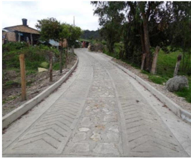
Figura 33. Vista de la vía intervenida El Empalizado
