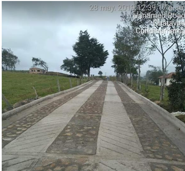
Figura 46. Sección tramo 2. 7 m de ancho
