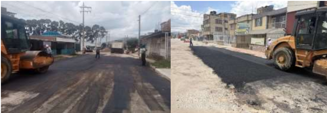
Ilustración 9 Compactación de Mezcla Asfáltica.
