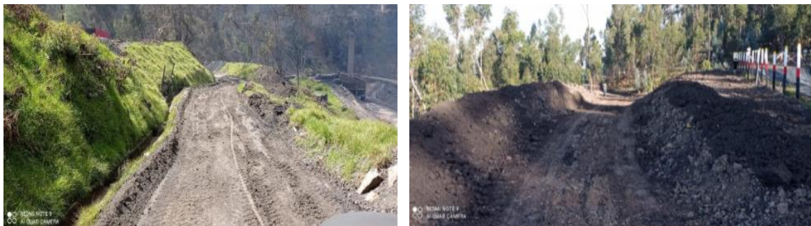
Figura 30. Adecuación de vías y patios
