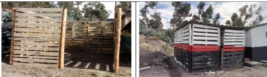
Figura 17. Creación depósito temporal de residuos sólidos
