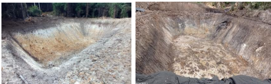
Figura 21. Perfilación de taludes
