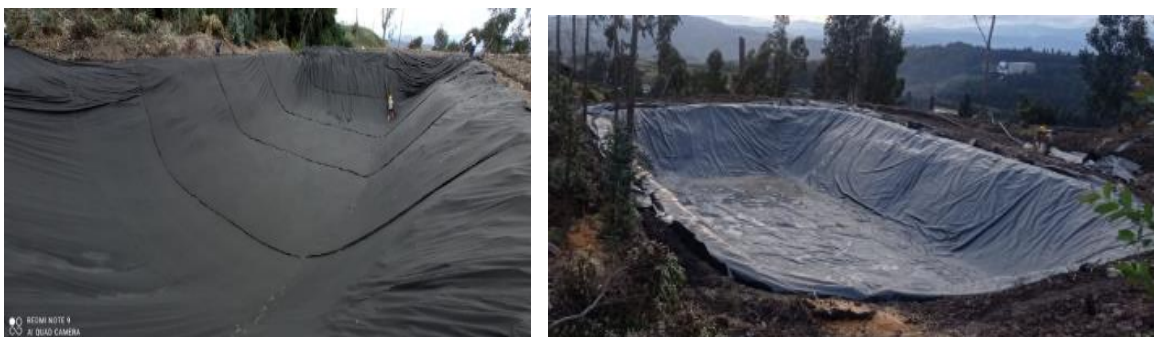
Figura 22. Impermeabilización de reservorios
