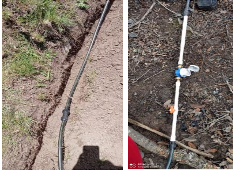
Figura 29. Instalación de mangueras para suministro de agua
