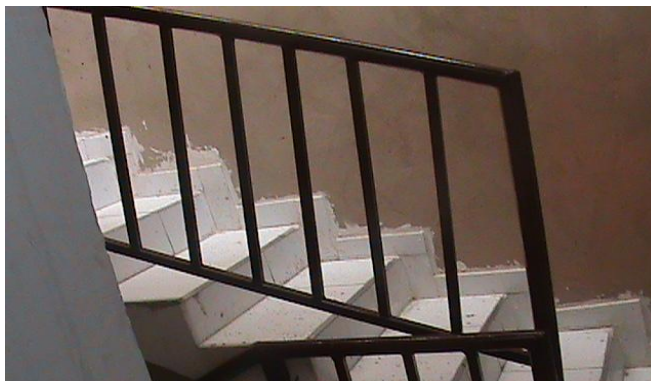
Figura 7. Estas son las barandas metálicas de la escalera de mi casa, en Mosquera que yo mismo las diseñe y las construí.
