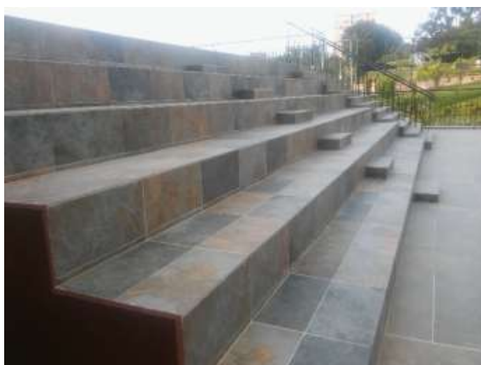
Figura 71. gradas ubicadas la plazoleta.
