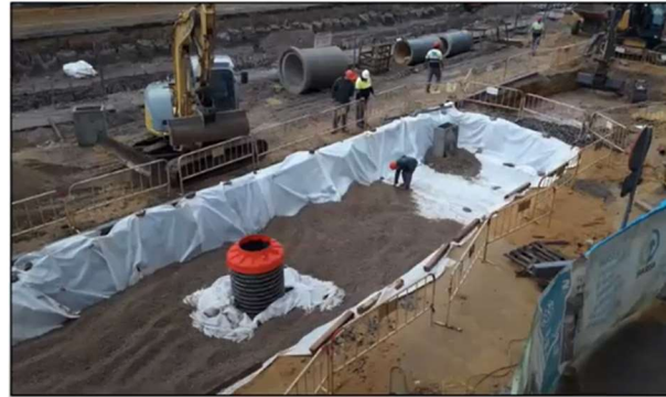
Figura 9.2. Drenajes, pozos y de inspección y sistemas de fusibles para bicarriles. SUDS Av. San Francisco Javier. Distrito Santa Justa – San Pablo. Sevilla.
