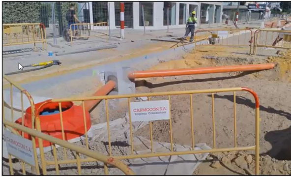
Figura 9.2. Drenajes, pozos y de inspección y sistemas de fusibles para bicarriles. SUDS Av. San Francisco Javier. Distrito Santa Justa – San Pablo. Sevilla.
