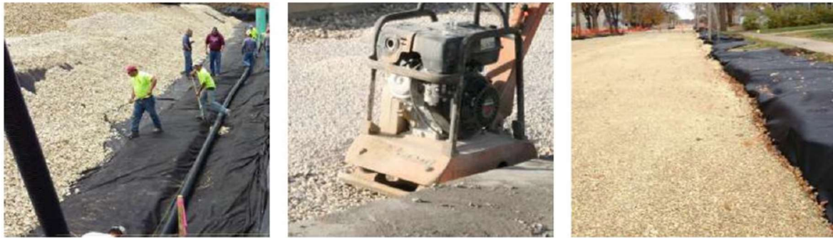
Figura 9.3. Colocación y compactación de agregados.
