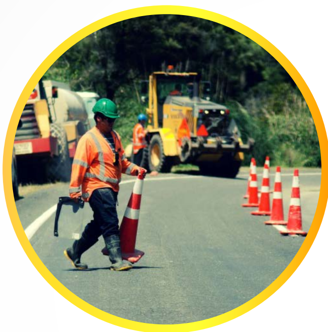
Figura 9. El trabajo de los asociados en la precooperativa de mantenimiento de vías
