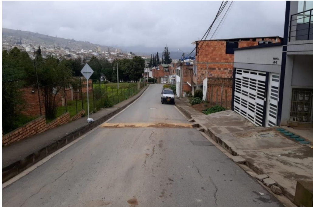
Figura 7. Fisuras longitudinales.
