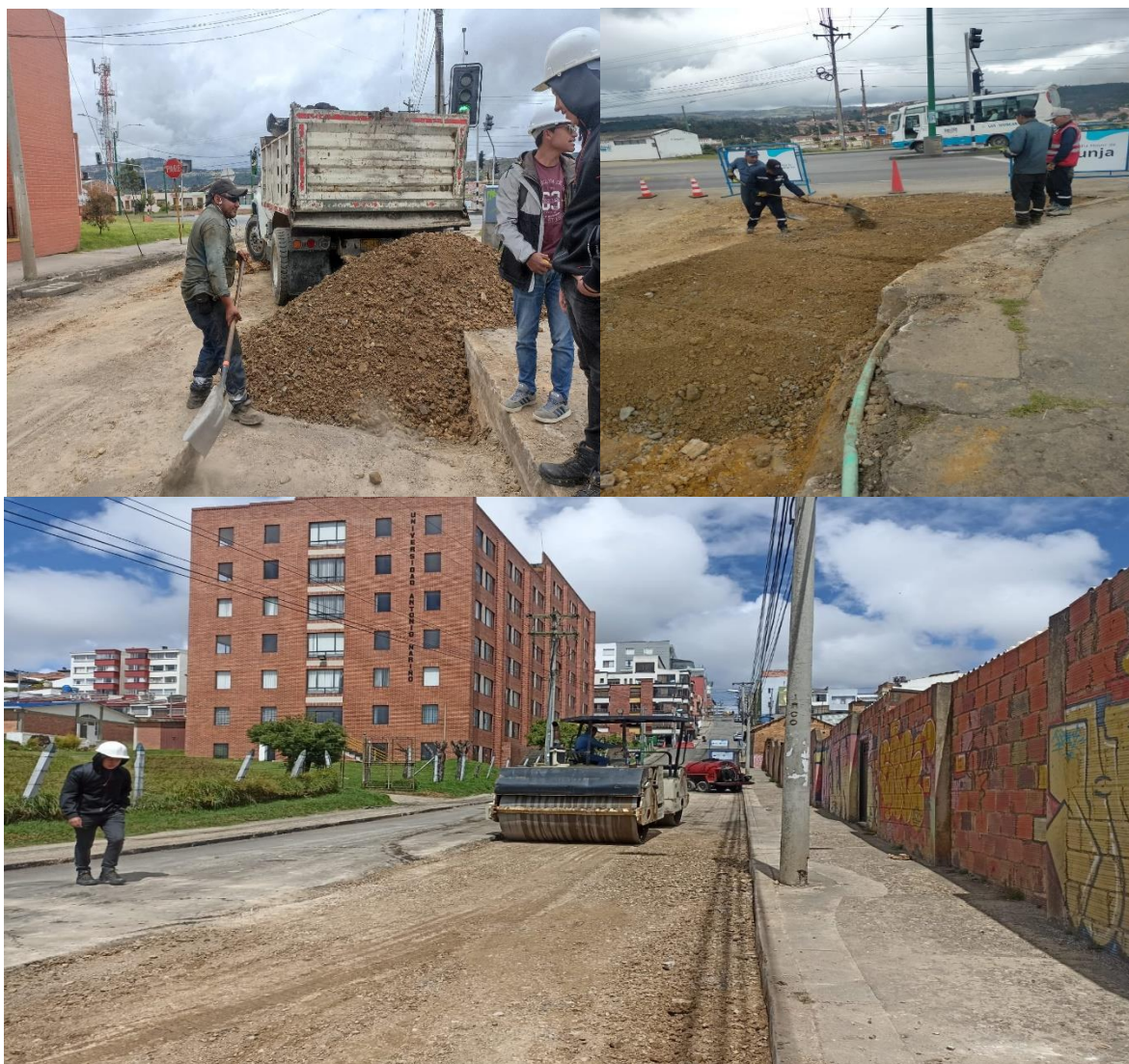
Figura 26. Suministro, extendida y compactación de material seleccionado para base granular del tramo bomberos.
