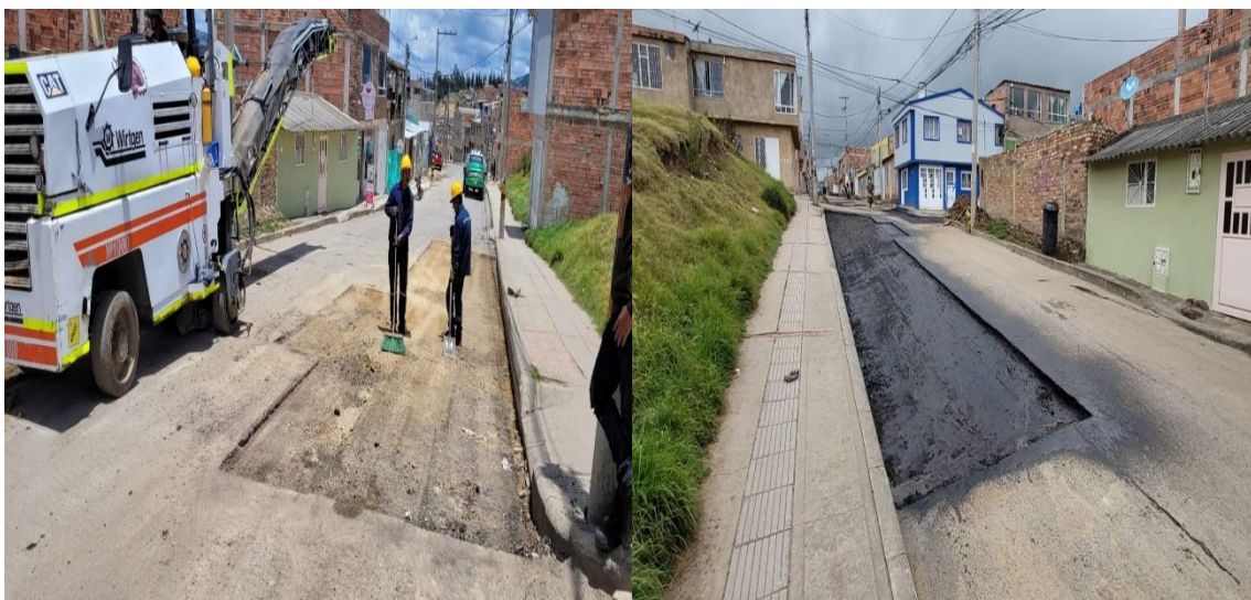
Figura 43. PK 6964 durante la ejecución tramo barrio patriotas.
