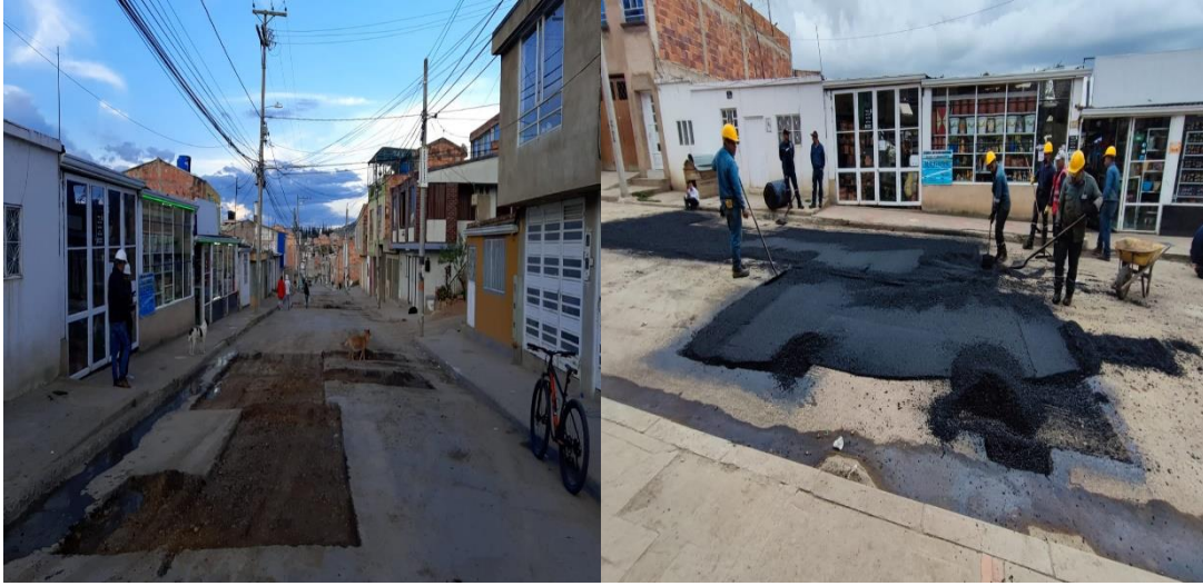
Figura 37. PK 6950 durante la ejecución tramo barrio patriotas.
