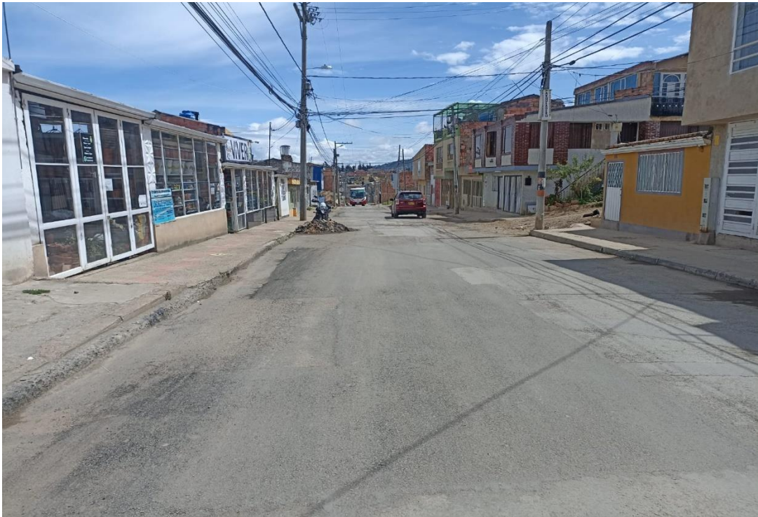
Figura 38. PK 6950 después la ejecución tramo barrio patriotas.
