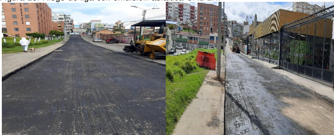
Figura 28. Riego de liga con emulsión asfáltica CRL-1H.
