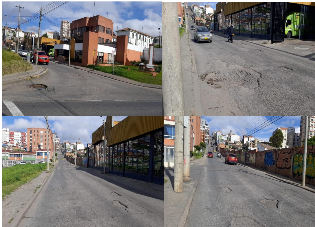
Figura 24. Antes del tramo bomberos.
