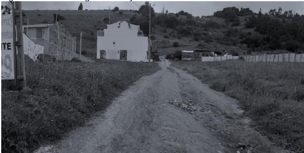
Figura 16. Surcos longitudinales y transversales.
