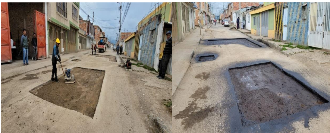
Figura 40. PK 6951 durante la ejecución tramo barrio patriotas.
