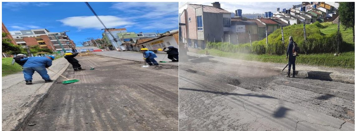
Figura 27. Barrido y soplado del tramo bomberos.
