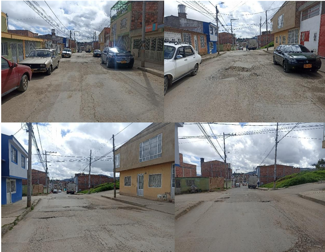
Figura 39. PK 6951 previo a la ejecución tramo barrio patriotas.
