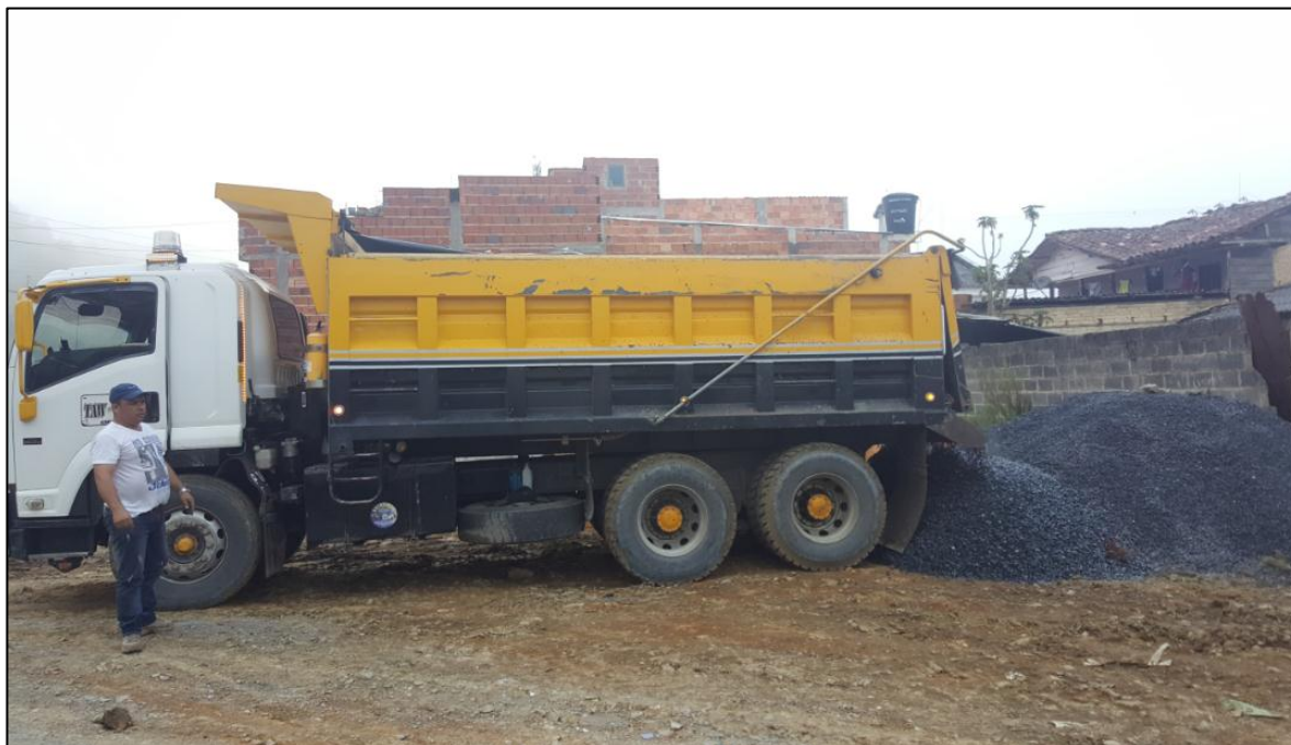
Ilustración 43. Recepción y revisión de materiales- PROCESO No. 004 – 2016, lote 1
