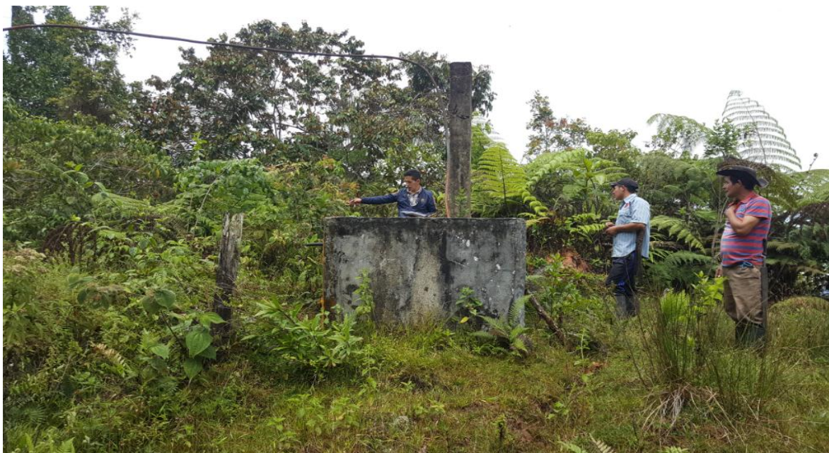
Ilustración 80. Tanque de almacenamiento – Vereda JUNIN
