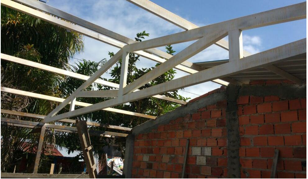
Ilustración 70. Cercha y correas Aula institución educativa rio blanco - Sede Girón
