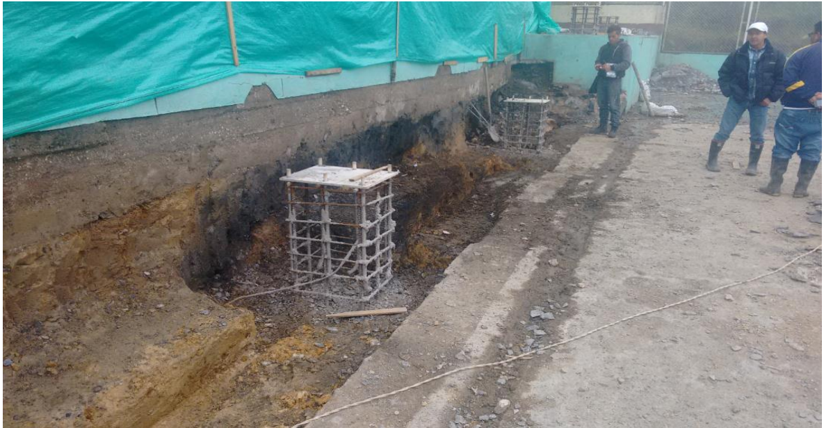
Ilustración 56. Zapatas fundidas – CUBIERTA POLIDEPORTIVO LAS CRUCES.
