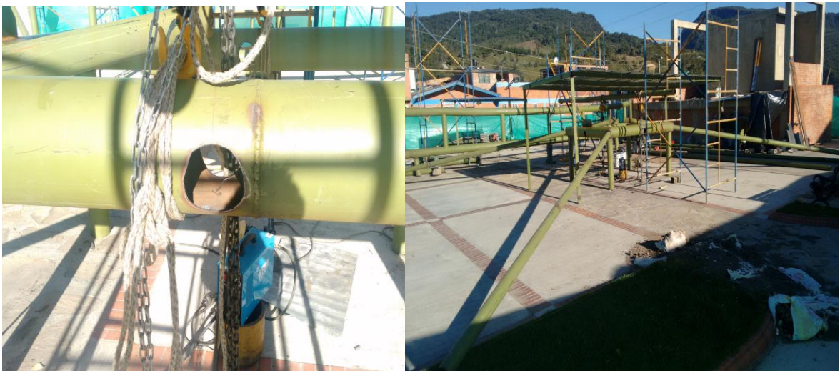
Ilustración 24. Estructura de soporte para la cubierta- Cubierta plazoleta polifuncional 11 de marzo.
