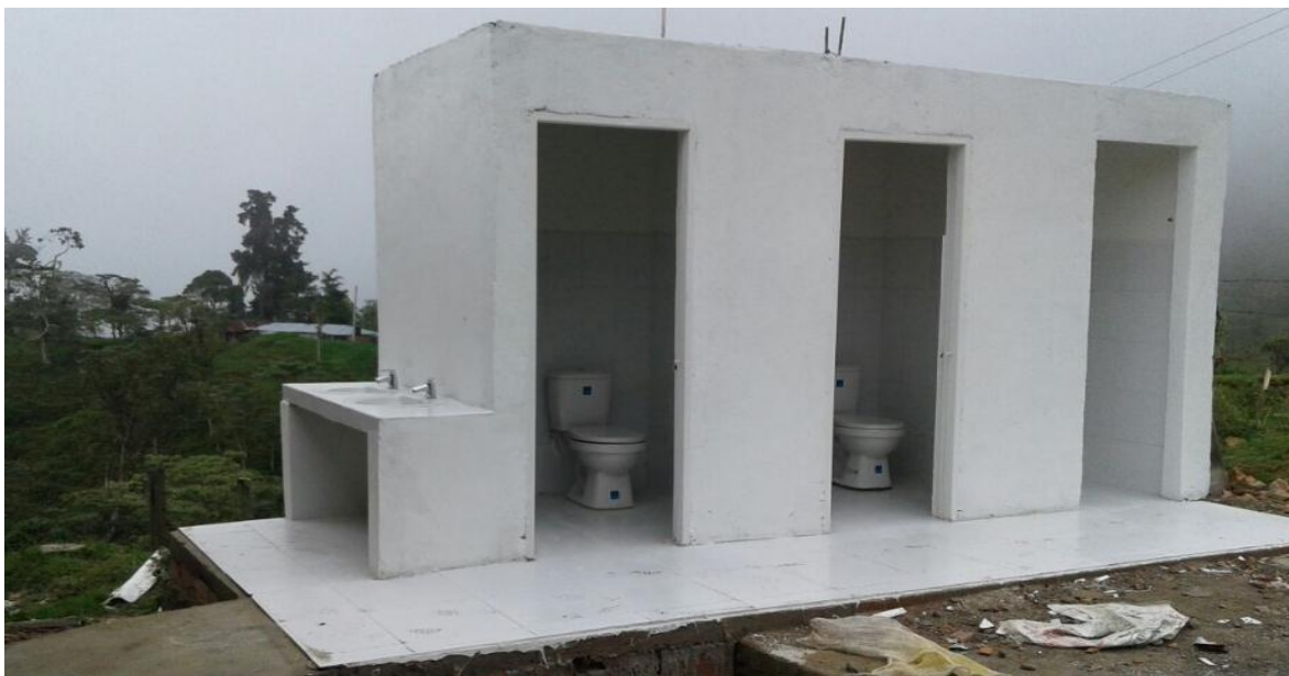
Ilustración 67. Construcción Bateria Sanitaria terminada - Vereda el venado
