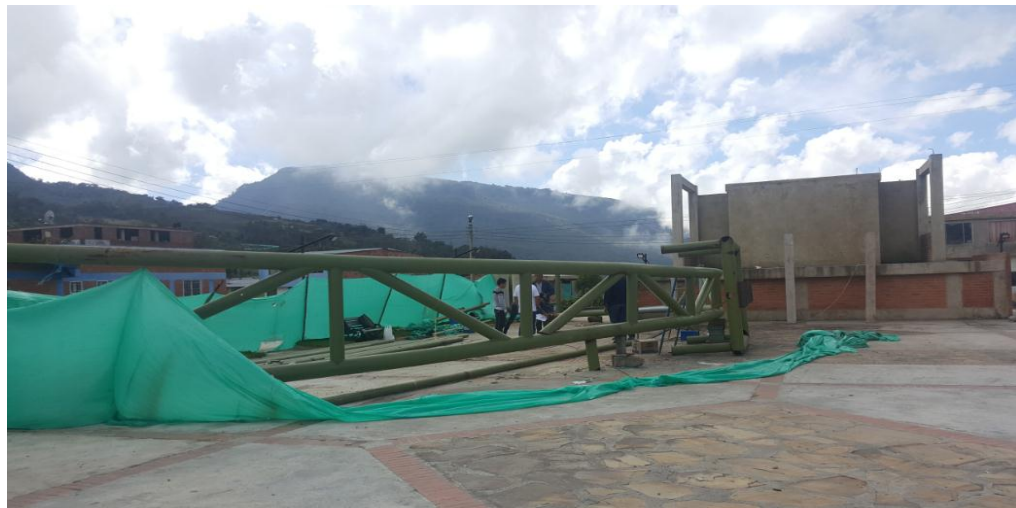
Ilustración 27. Revisión del estado de la estructura y toma de decisiones
