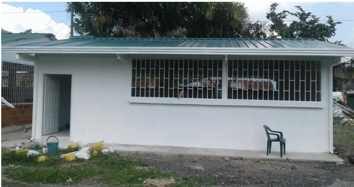
Ilustración 72. Construcción Aula institución educativa rio blanco terminada - Cede Girón
