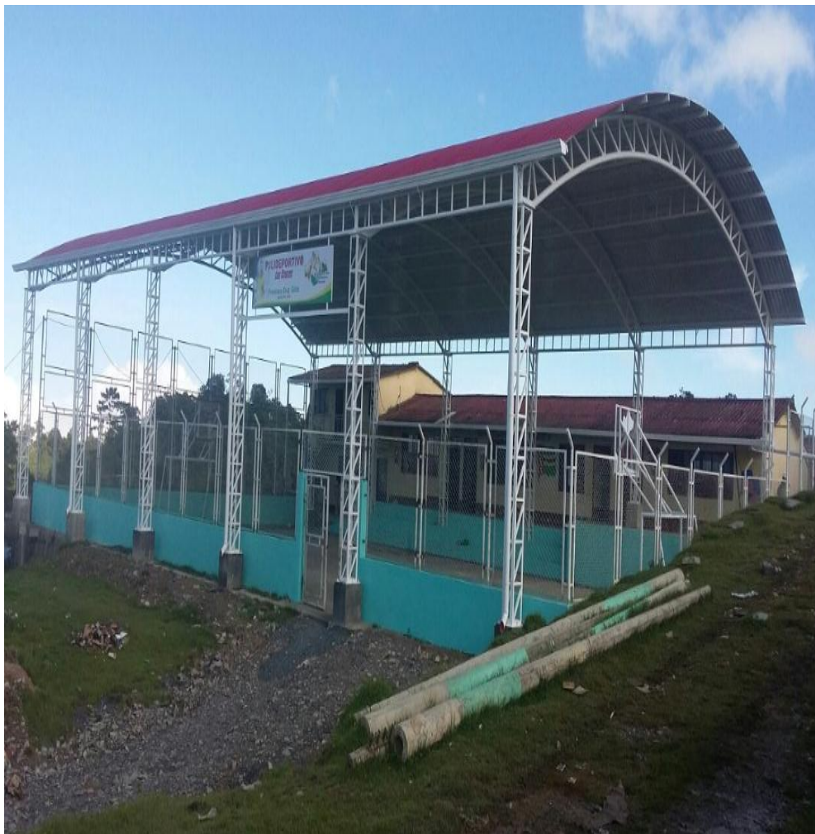
Ilustración 62. Cubierta finalizada - CUBIERTA POLIDEPORTIVO LAS CRUCES
