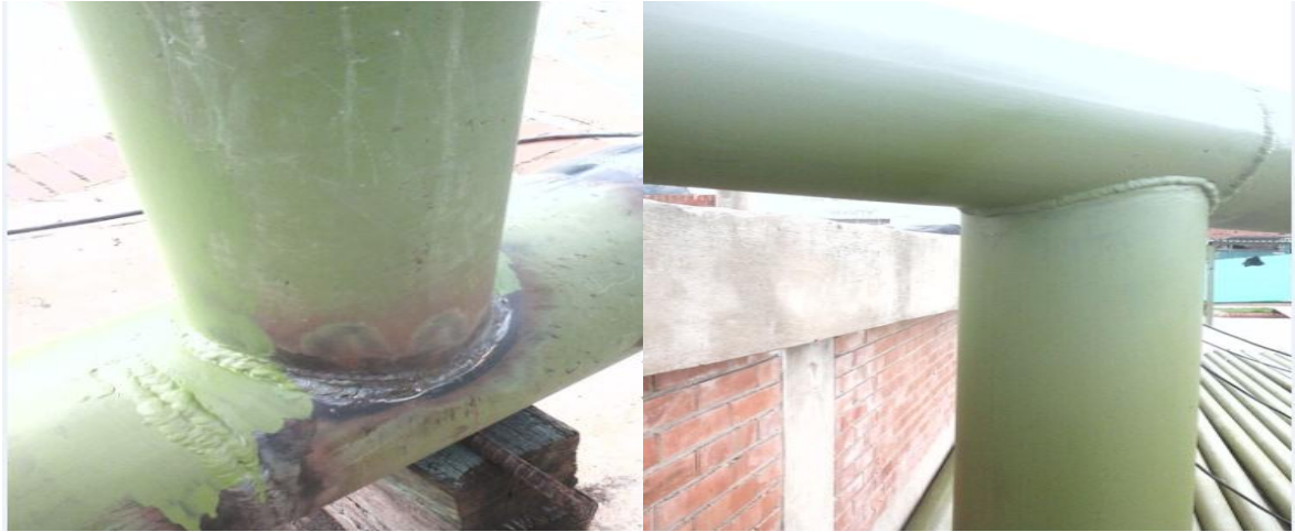
Ilustración 21. Soldadura metálica terminada con aplicación de pintura anticorrosiva
