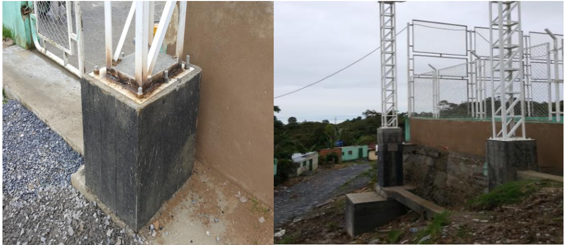
Ilustración 58. Pedestales fundidos y celosías instaladas - CUBIERTA POLIDEPORTIVO LAS CRUCES.
