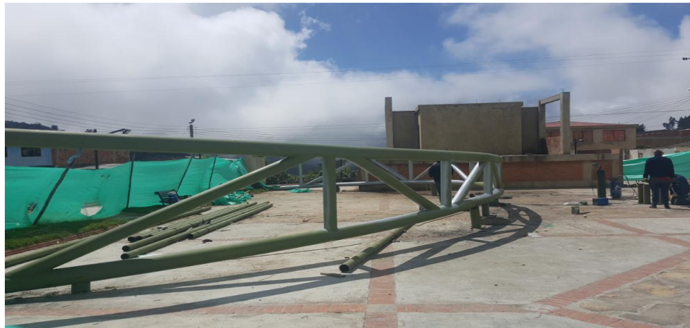
Ilustración 28. Reinicio de labores estructura cubierta polifuncional 11 de marzo
