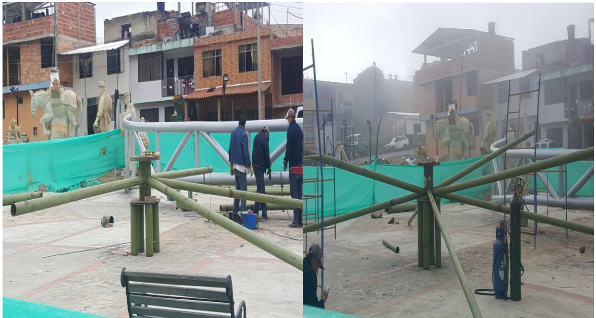
Ilustración 30. Estructura Tubo central de soporte para la cubierta en lona Ferrari
