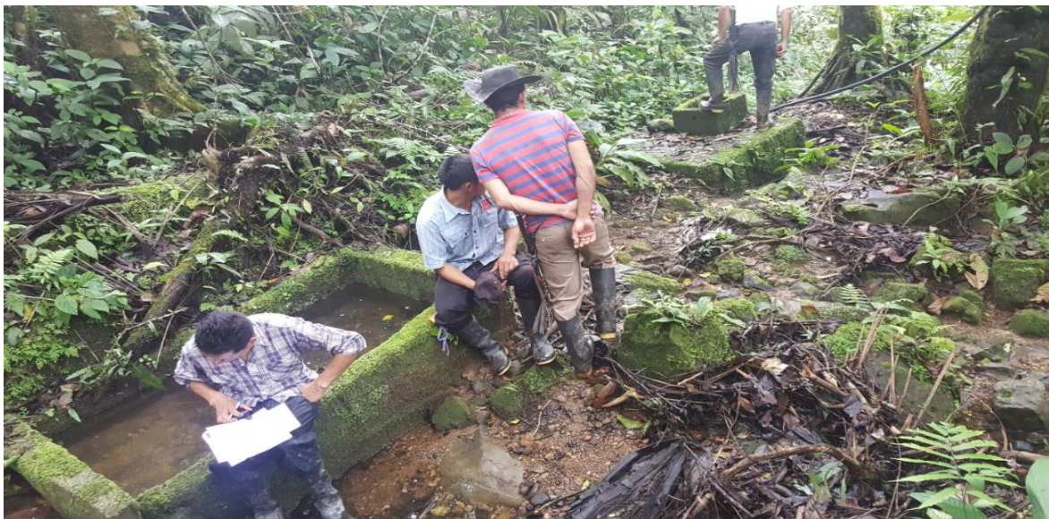
Ilustración 81. Tanque de almacenamiento – Vereda JUNIN
