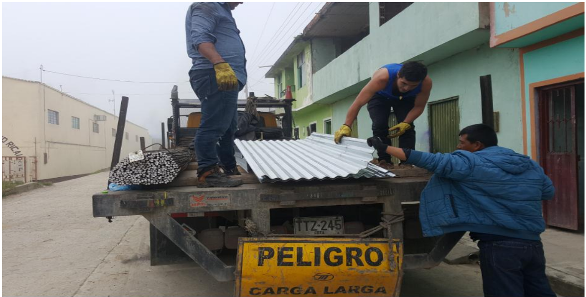
Ilustración 47. Recepción y revisión de materiales- PROCESO No. 004 – 2016, lote 3
