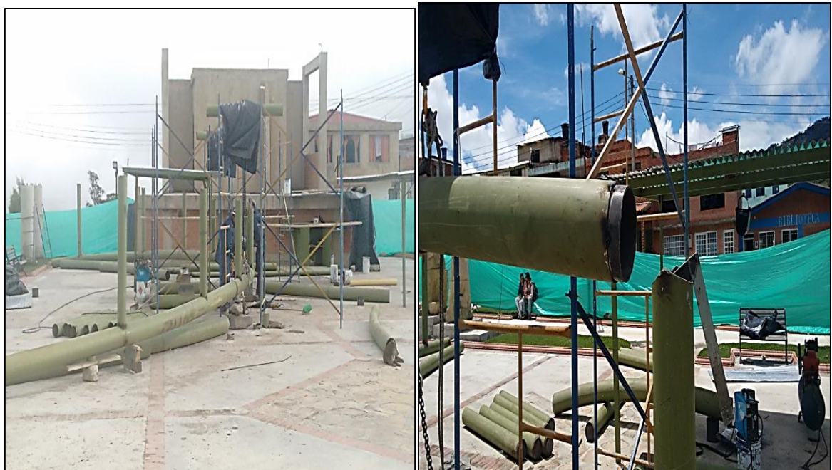
Ilustración 18. Cercha principal de cubierta – Cubierta plazoleta polifuncional 11 de marzo.
