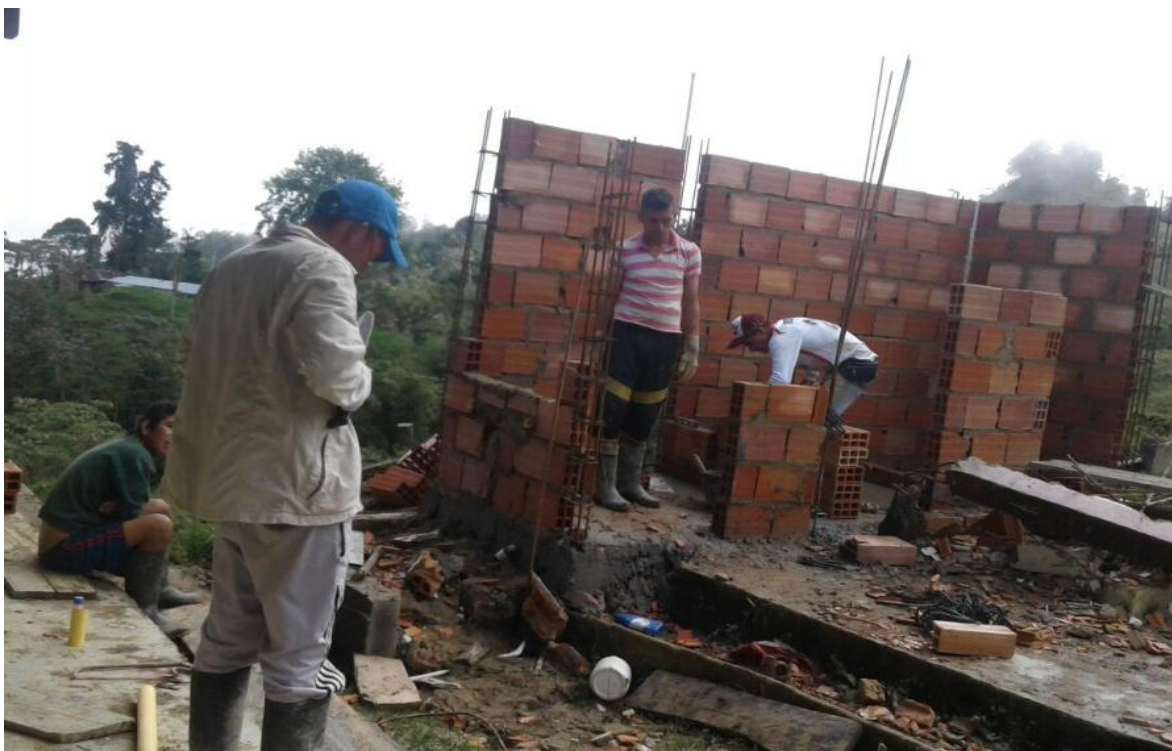
Ilustración 66. Proceso constructivo Bateria Sanitaria- Vereda el venado
