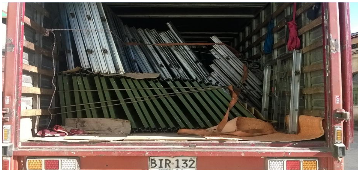
Ilustración 49. Recepción y revisión de materiales- PROCESO No. 004 – 2016, lote 4
