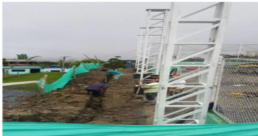
Ilustración 59. Celosías en estructura metálica - CUBIERTA POLIDEPORTIVO LAS CRUCES.
