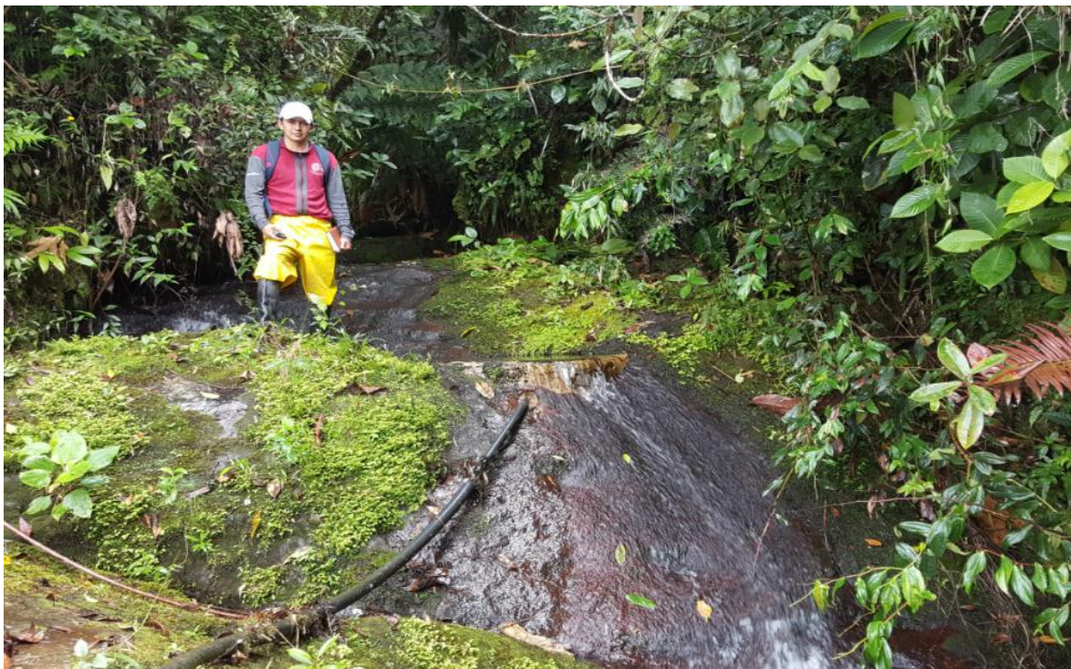
Ilustración 78. Bocatoma Acueducto – Vereda JUNIN
