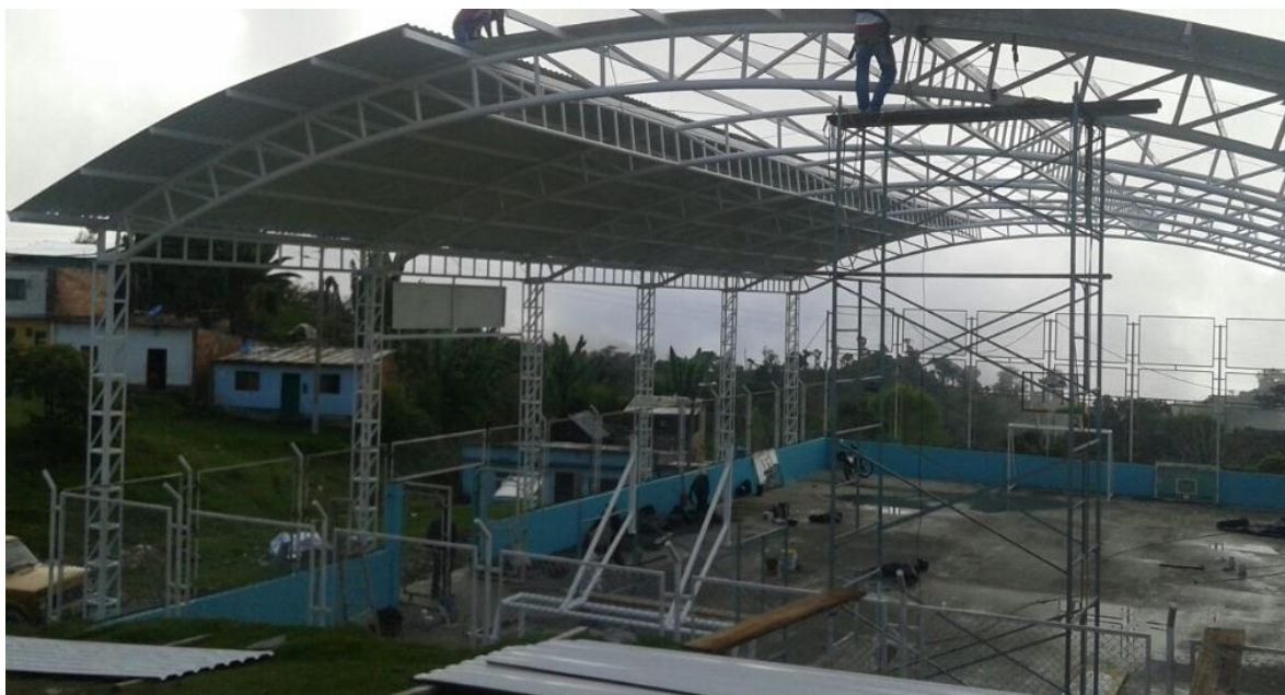
Ilustración 61. Instalación de la teja termo acústica- CUBIERTA POLIDEPORTIVO LAS CRUCES
