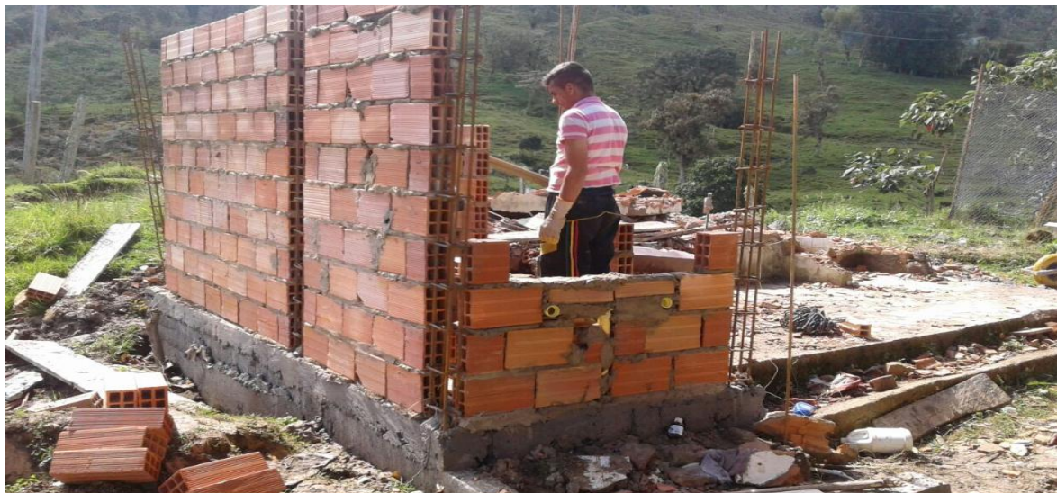
Ilustración 65. Proceso constructivo Batería Sanitaria- Vereda el venado
