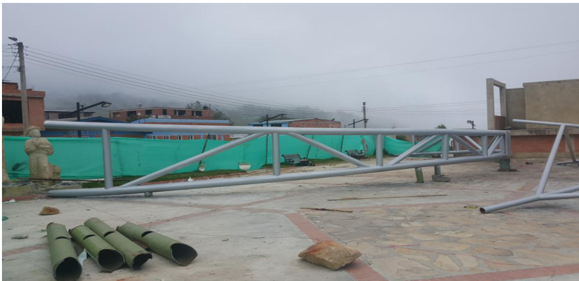
Ilustración 31. Estructura arco principal terminado y listo para su montaje
