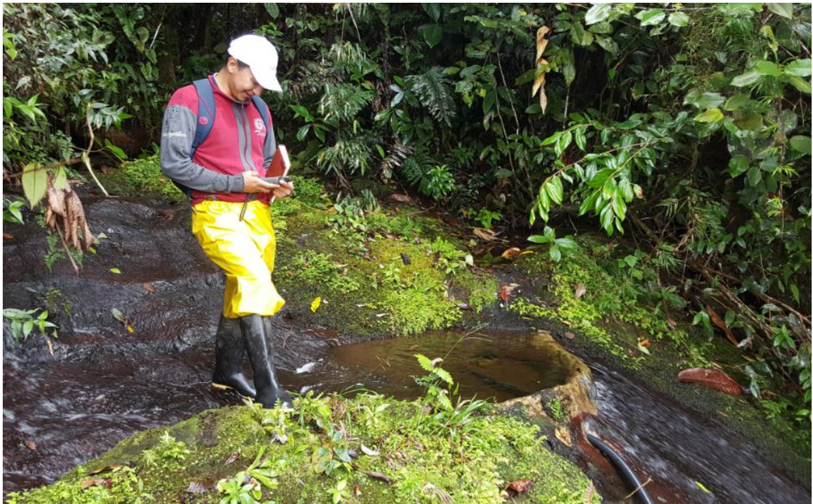
Ilustración 77. Bocatoma Acueducto – Vereda JUNIN
