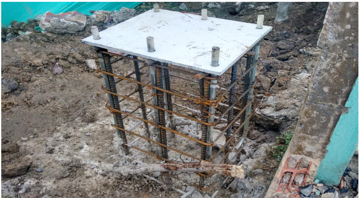
Ilustración 57. Refuerzos de pedestales y platina de anclaje - CUBIERTA POLIDEPORTIVO LAS CRUCES.
