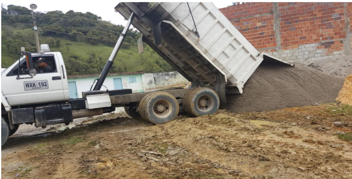
Ilustración 42. Recepción y revisión de materiales- PROCESO No. 004 – 2016, lote 1
