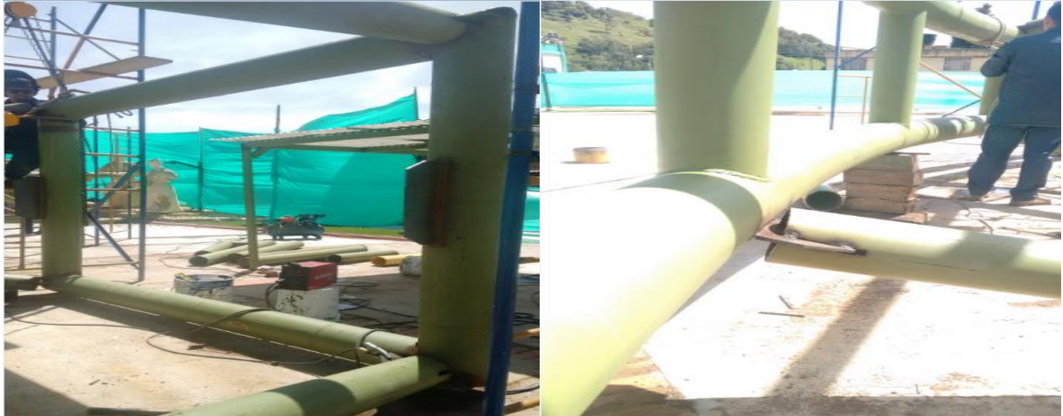
Ilustración 23. Estructura en forma de cajón encargada de soportar la lona Ferrari
