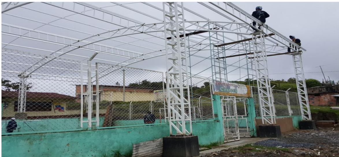
Ilustración 60. Cerchas metálicas y correas en perfil estructural - CUBIERTA POLIDEPORTIVO LAS CRUCES
