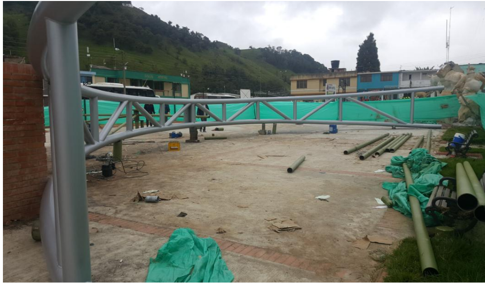
Ilustración 29. Estructura retocada con anticorrosivo y pintada en color plateado o metal
