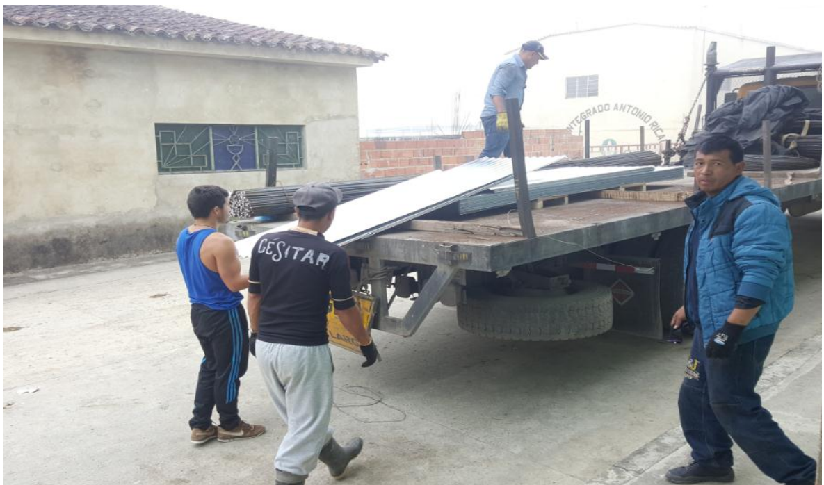
Ilustración 48. Recepción y revisión de materiales- PROCESO No. 004 – 2016, lote 3
