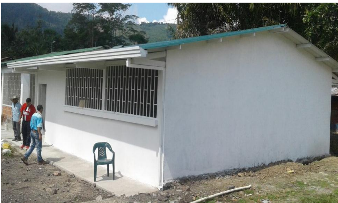
Ilustración 73. Construcción Aula institución educativa rio blanco terminada - Cede Girón
