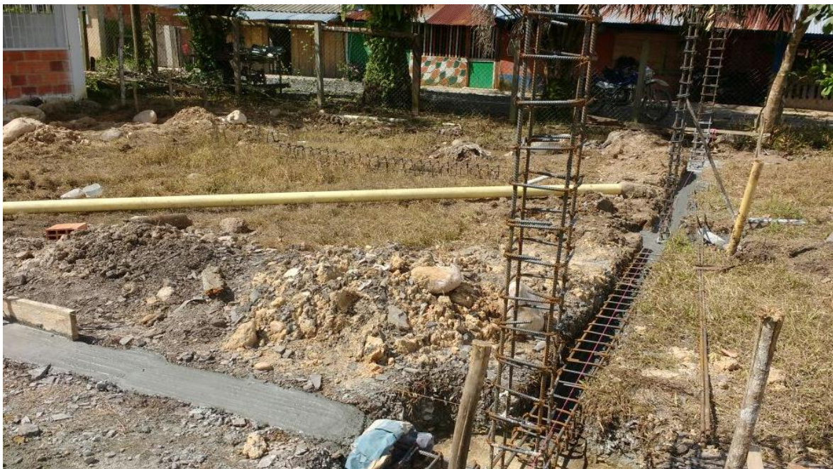
Ilustración 68. Proceso constructivo Aula institución educativa rio blanco - Sede Girón
