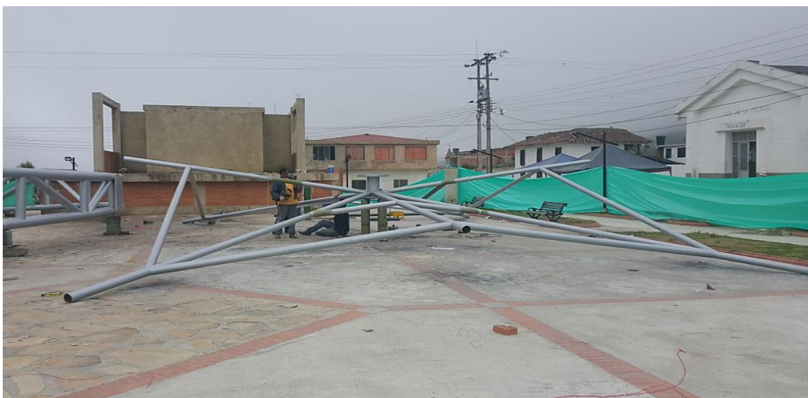
Ilustración 32. Estructura central de soporte terminada y pintada lista para su posterior instalación y montaje
