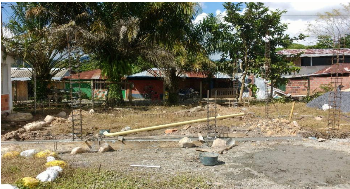
Ilustración 69. Proceso constructivo Aula institución educativa rio blanco - Sede Girón
