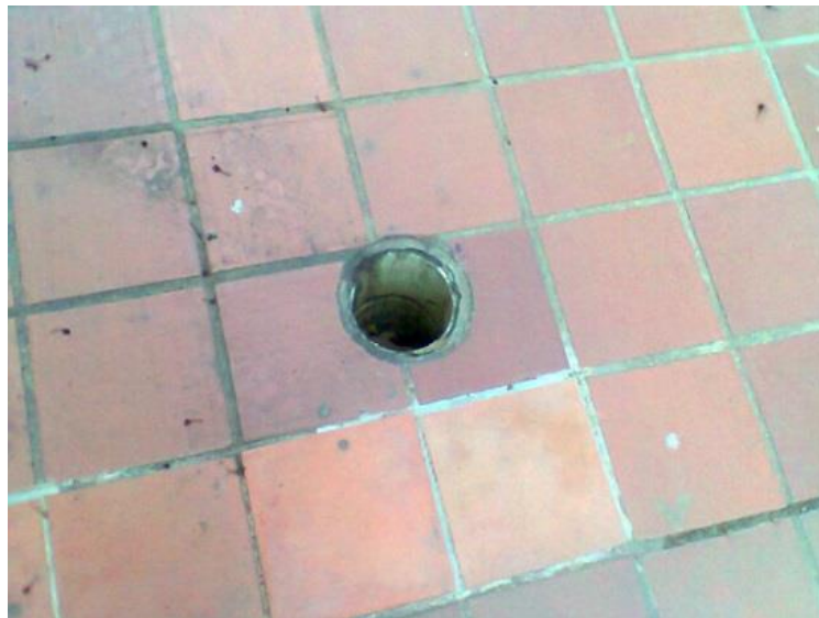
Desagüe zona de circulación
