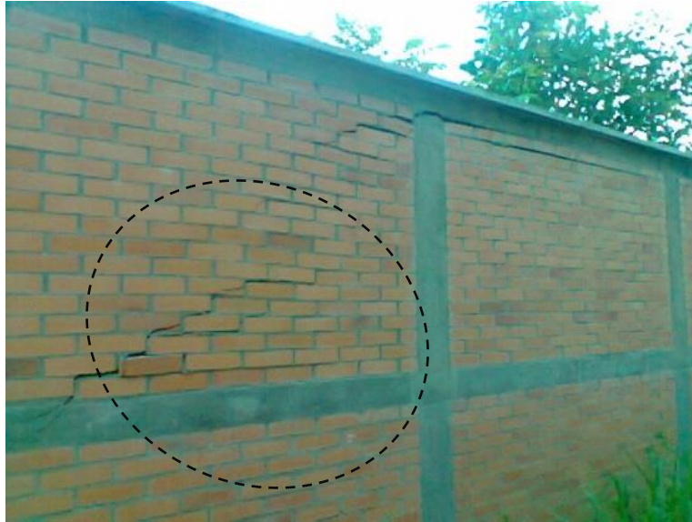
Muro de cerramiento posterior
