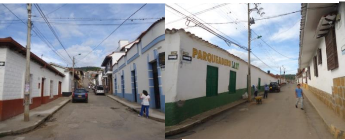
Figura 15. Acceso a vías
