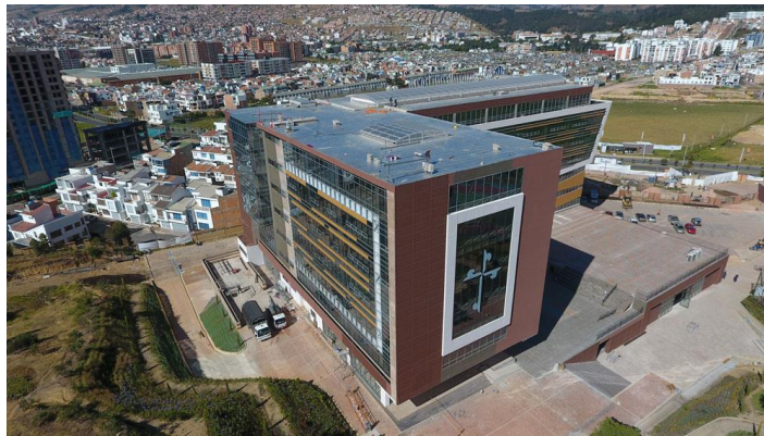
Ilustración 5. Edificio Santo Domingo USTA Tunja 2019
