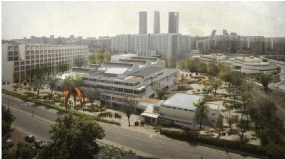
Figura 42. Renovación de la Planta de Leche Clesa.
