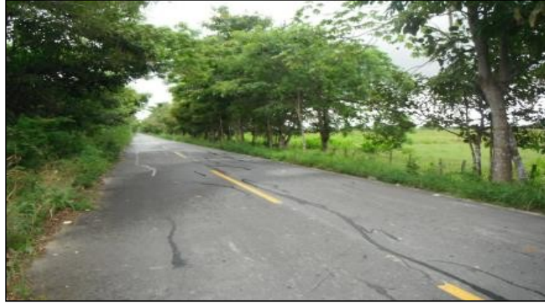
Figura 26 Fotografía Tomada sobre la Vía que Conduce hacia la Vereda Caracol. Fuente: Elaboración propia.
