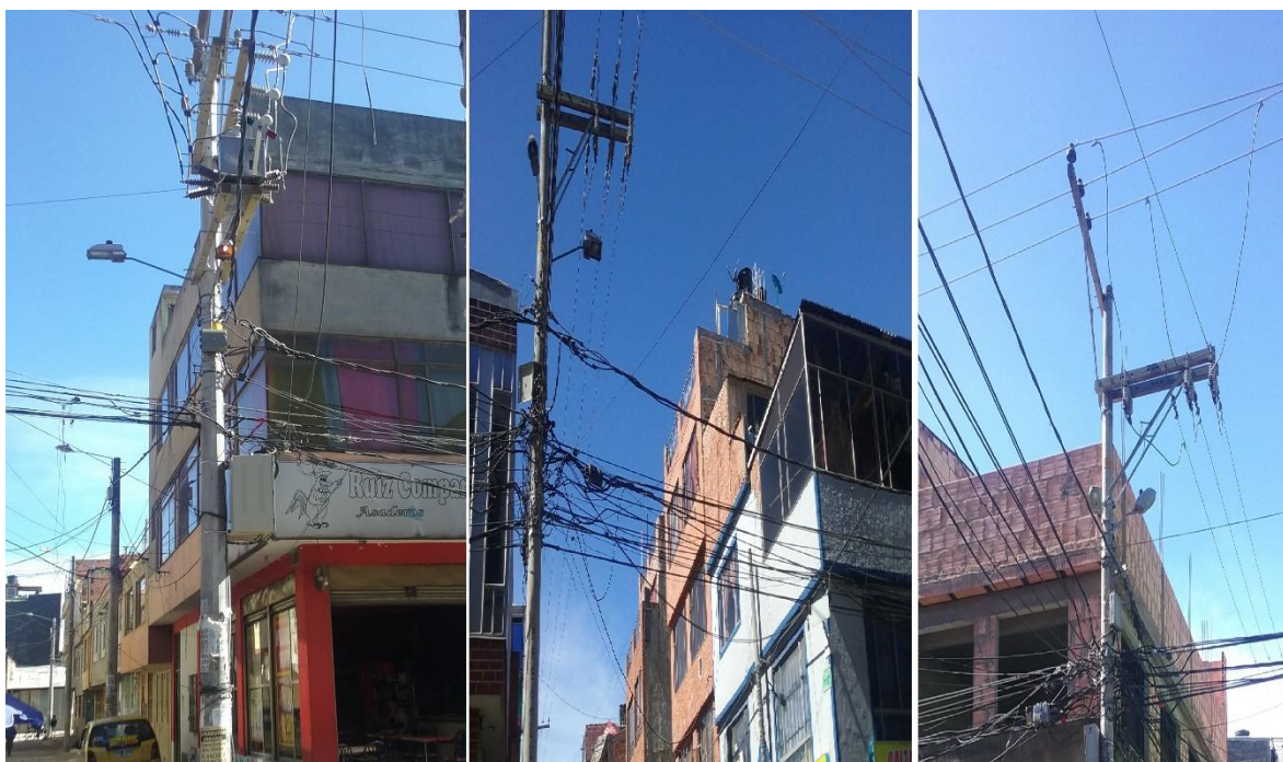
Figura 23 Obstrucciones visuales para las cámaras. (proyecto, 2017)
