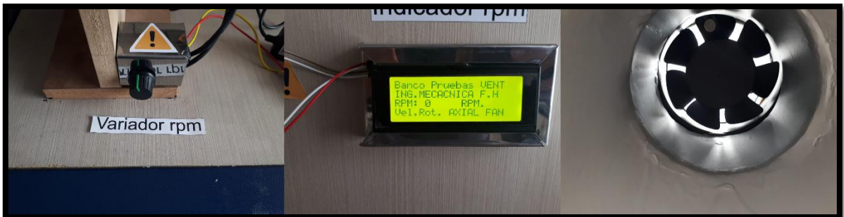
Figura 12. Perilla de control de manómetro en velocidad 0.
