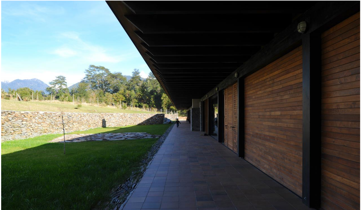
Figura 31. Toma Fotográfica Hotel Lago Rupanco
