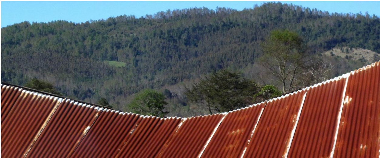
Figura 11. Cubierta Hotel Panguipulli.
