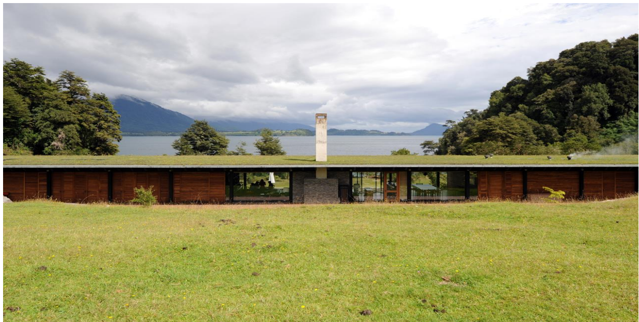
Figura 30. Toma fotográfica Hotel Lago Rupanco
