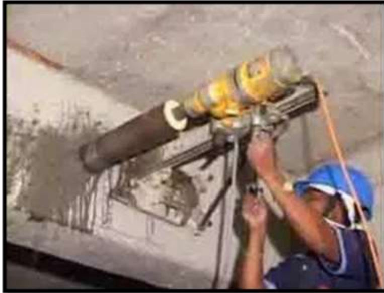
Figura 5: Máquina extracción de núcleos Fuente: Yo Ingeniero (2019).
