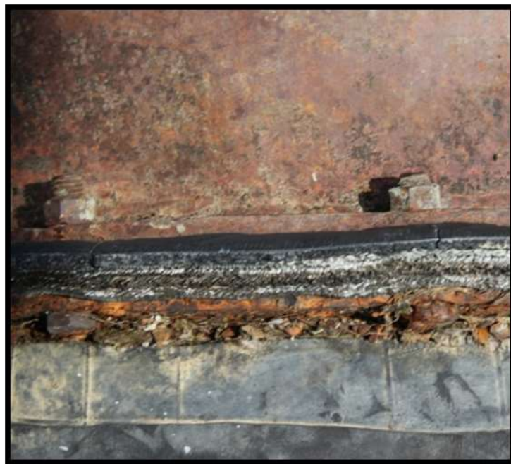
Figura 27: Neopreno detalle unión bridada
