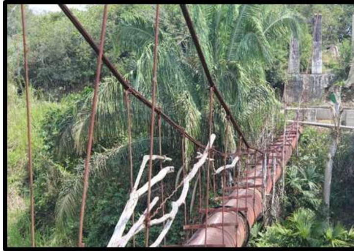
Figura 2: Panorámica del acueducto elevado Fuente: los autores.
