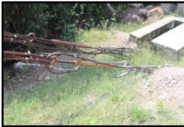
Figura 14: Llegada de cables al macizo de anclaje
