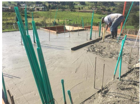
Ilustración 10: Fundición de Placa de Entrepiso Casa N°13 y N°14 Flor de Campo
