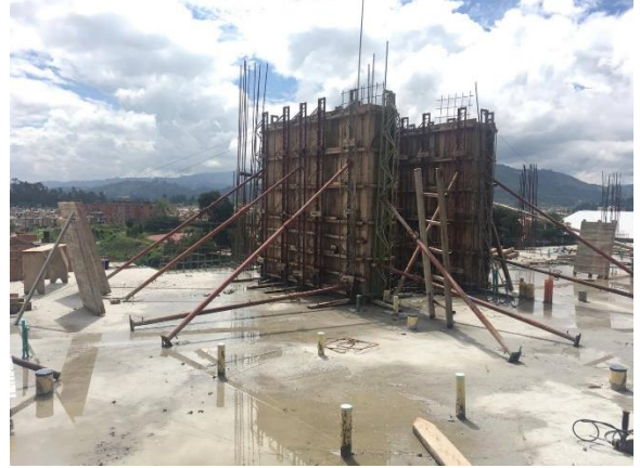
Ilustración 22: Fundición de Muros Pantalla Escaleras Piso 6 Edificio Río Parque Residencial.
