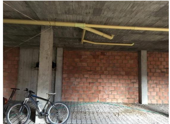
Ilustración 14: Tuberías descolgadas parqueadero Edificio Lotus.
