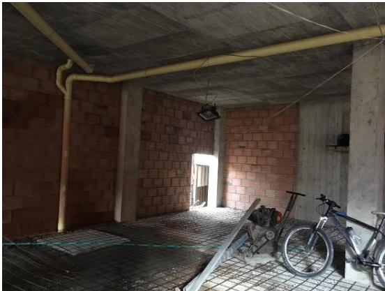
Ilustración 14: Tuberías descolgadas parqueadero Edificio Lotus.
