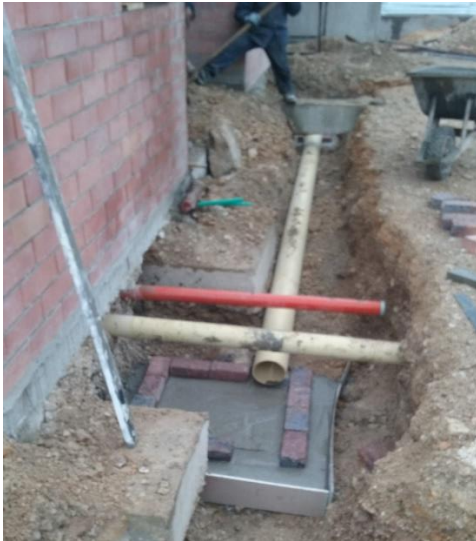
Ilustración 35: Construcción Cajas de Inspección Aguas Negras y Aguas Lluvias Casa Modelo Parque Residencial.
