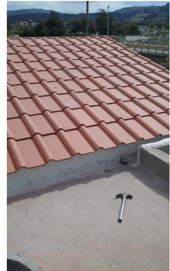
Ilustración 39: Impermeabilización de Cubierta Casa Modelo Parque Residencial
