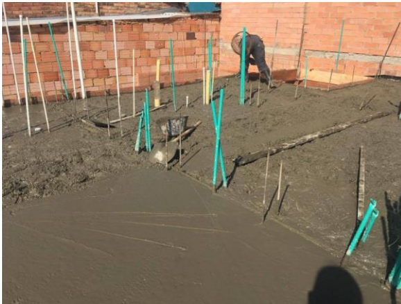
Ilustración 10: Fundición de Placa de Entrepiso Casa N°13 y N°14 Flor de Campo
