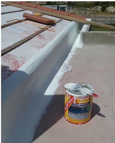
Ilustración 39: Impermeabilización de Cubierta Casa Modelo Parque Residencial
