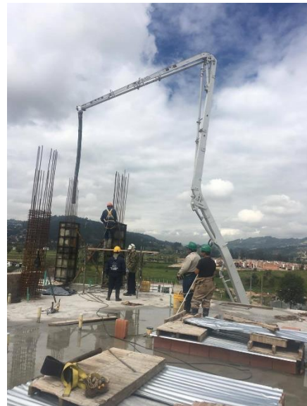
Ilustración 21: Fundición de Columnas para Muros Pantalla Piso 6 Edificio Río Parque Residencial
