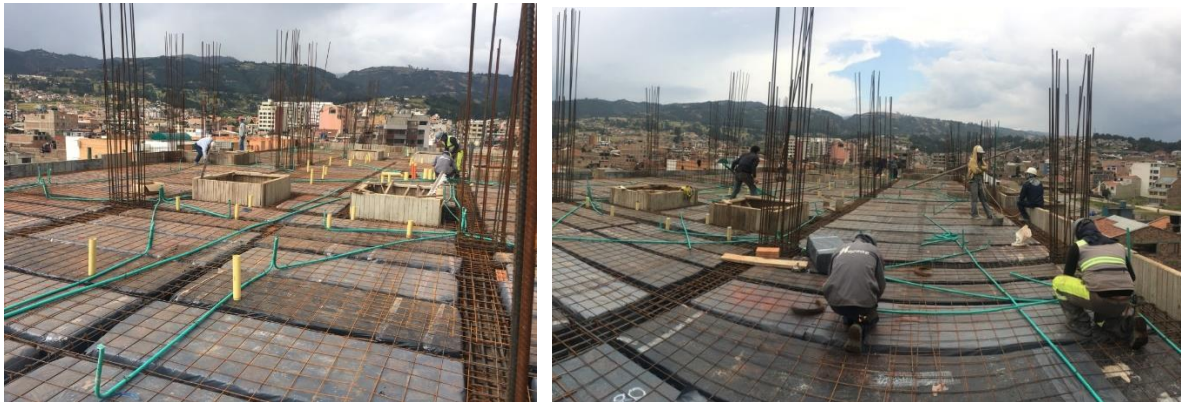
Ilustración 19:Alistamiento Fundición Placa Aligerada N°5 Edificio Río Parque Residencial
