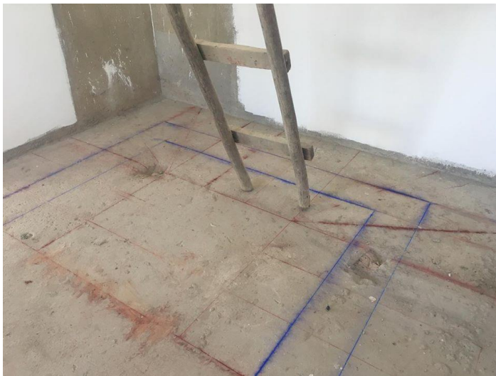
Ilustración 29: Trazado en Obra vista en Planta de Escalera en Voladizo.
