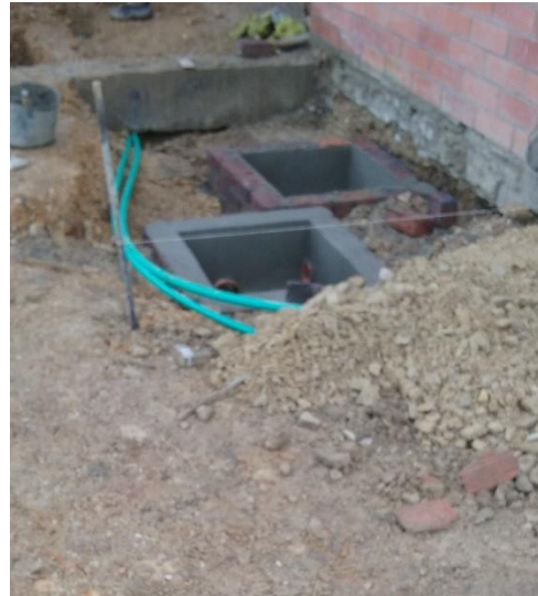
Ilustración 35: Construcción Cajas de Inspección Aguas Negras y Aguas Lluvias Casa Modelo Parque Residencial.
