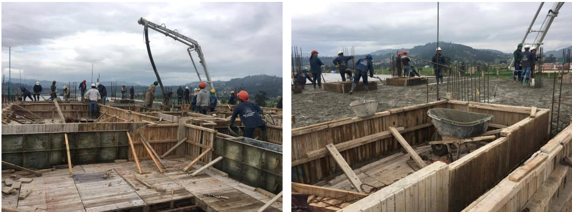
Ilustración 25: Fundición de Placa Entrepiso N°6 Edificio Río Parque Residencial.
