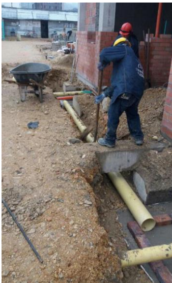
Ilustración 36: Conexión entre cajas de Inspección Casa Modelo y Casa N°2 Río Parque Residencial
