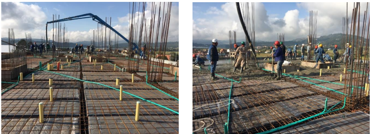
Ilustración 20:Fundición Placa Aligerada N°5 Edificio Río Parque Residencial
