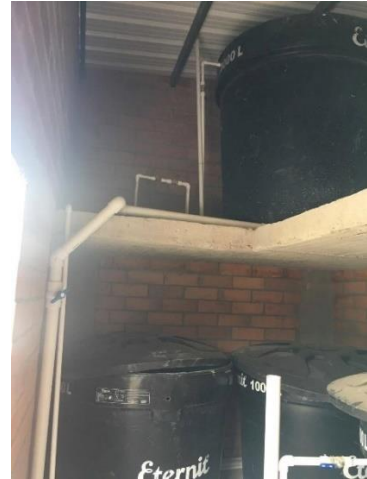
Ilustración 13: Placa para tanques de almacenamiento de agua Edificio Lotus
