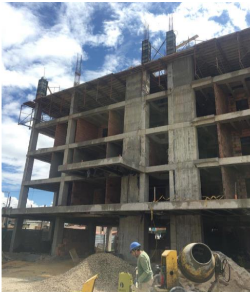
Ilustración 21: Fundición de Columnas para Muros Pantalla Piso 6 Edificio Río Parque Residencial
