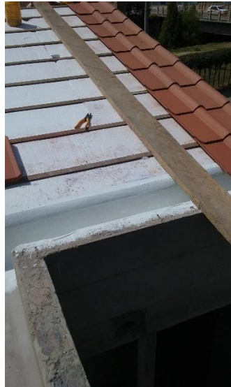
Ilustración 39: Impermeabilización de Cubierta Casa Modelo Parque Residencial
