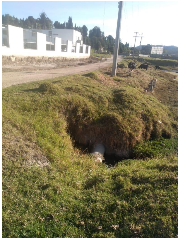
Fotografía 1. Supervisión a la actividad de preliminares del contrato 218/2019
