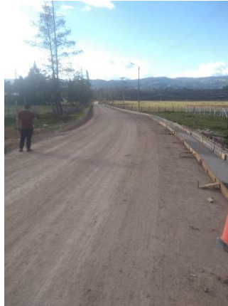
Fotografía 16. Supervisión técnica a la construcción de la vía bienestarina – sector Tunguavita del contrato 016/2015
