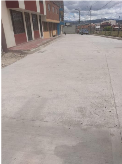
Fotografía 6. Supervisión técnica a la obra terminada calle 27 del contrato 265/2019
