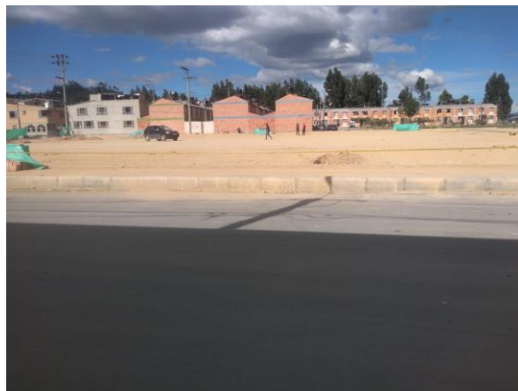
Fotografía 8. Supervisión técnica a la construcción del multiparque del barrio el bosque del contrato 265/2019
