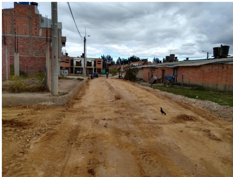
Fotografía 9. Supervisión técnica de vías del barrio senderos del contrato 265/2019
