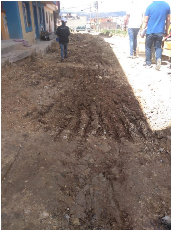
Fotografía 5. Supervisión técnica calle 27 a la actividad de explanaciones del contrato 265/2019
