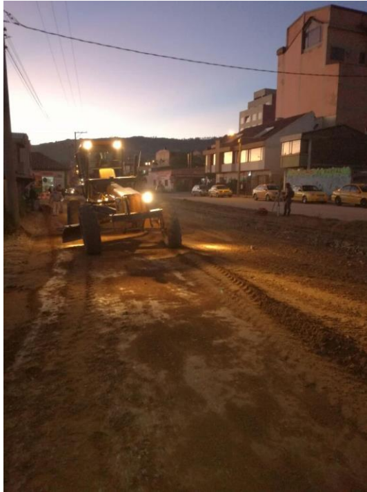
Fotografía 11. Supervisión técnica actividades de afirmado sub base granular del contrato 231/2019
