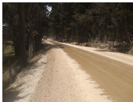
Fotografía 17. Supervisión técnica a la construcción de la vía hotel colonial – casona del salitre para el contrato 016/2015
