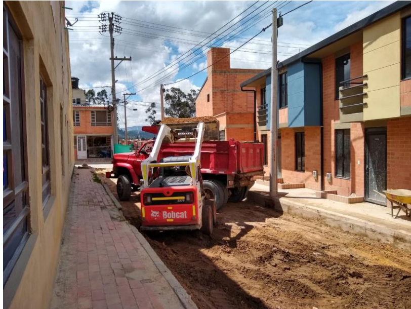
Fotografía 10. Supervisión técnica a la construcción de la vía en el barrio nuevo horizonte del contrato 265/2019
