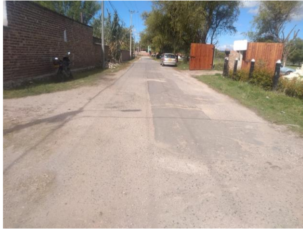
Fotografía 7. Supervisión técnica a la obra de re parcheo carrera 26 del contrato 265/2019
