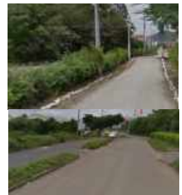
ESTADO ACTUAL DE LAS VIAS.
