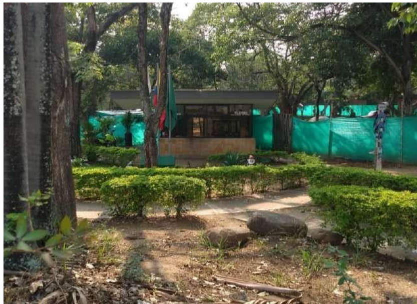
Figura 3. Estado del CAI de Cañaveral ubicado en el parque la pera frente al centro comercial Cañaveral.
