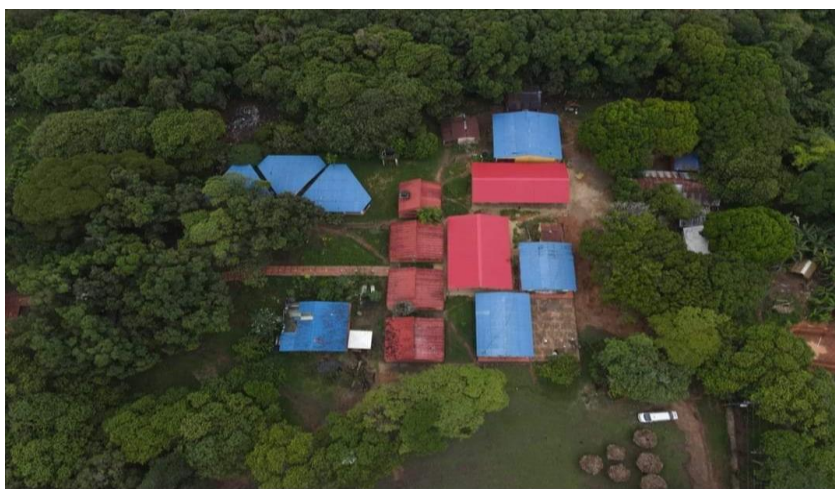
Figura 4. Construcciones de la Institución Educativa Kuwei, Puerto Gaitán, Meta.
