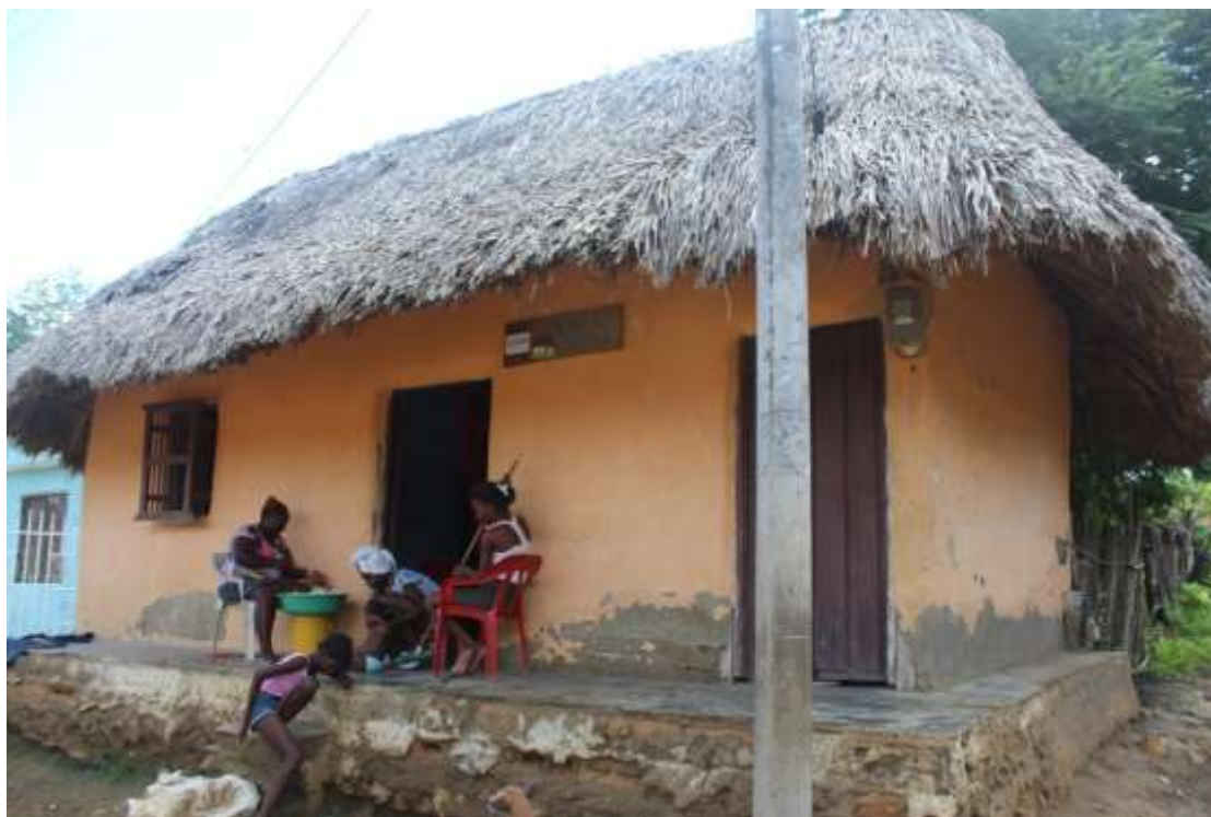
Imagen 4-1: Casa en construcción tradicional en bahareque
