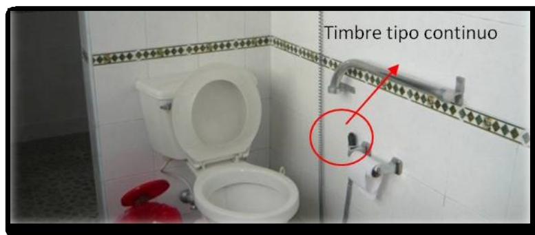
Figura 76. Baño con Timbre Tipo Continuo
