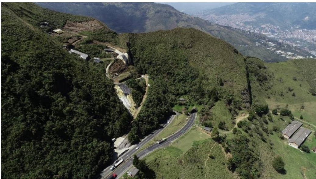
Fotografía 12. Túneles del kilómetro 13. Fuente: Propia
