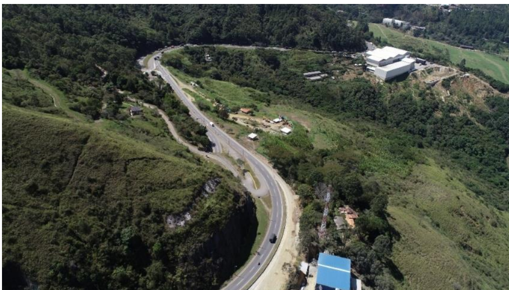
Fotografía 11. Túnel del kilómetro 6. Fuente: Propia
