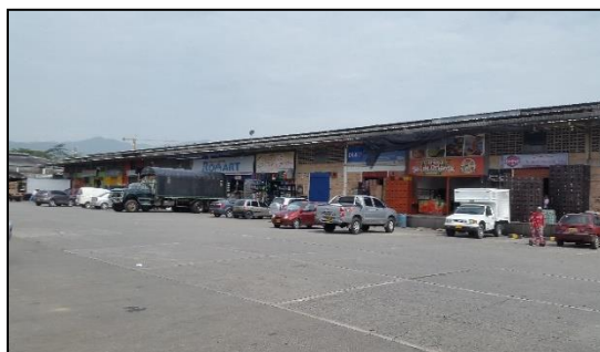
Figura 5. Vista panorámica de la bodega C, por Gina Delgado
