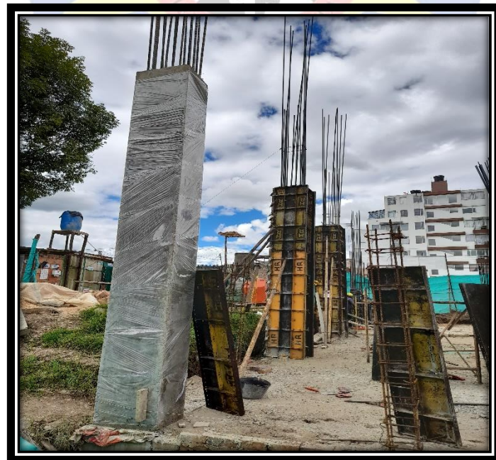
Ilustración 61: Columna Tipo (A)5 - Colocada
