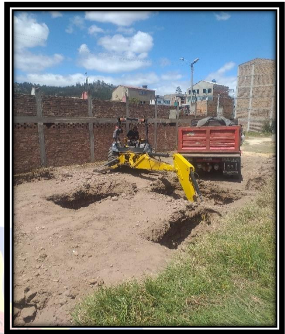
Ilustración 10: Excavación de Zapatas
