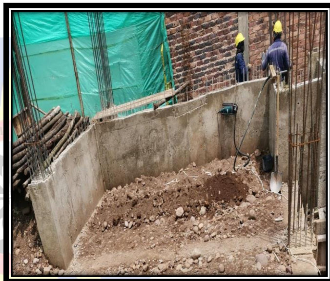
Ilustración 51: Muro de Contención Colocado
