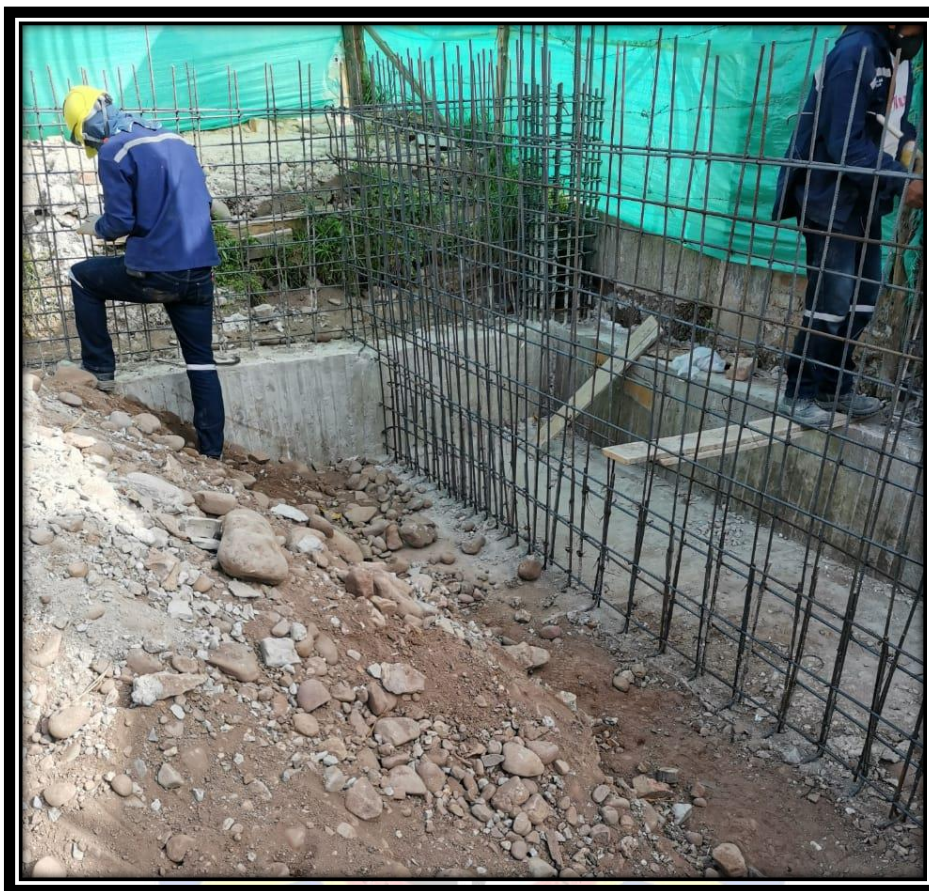
Ilustración 50: Muro de Contención - Figurado
