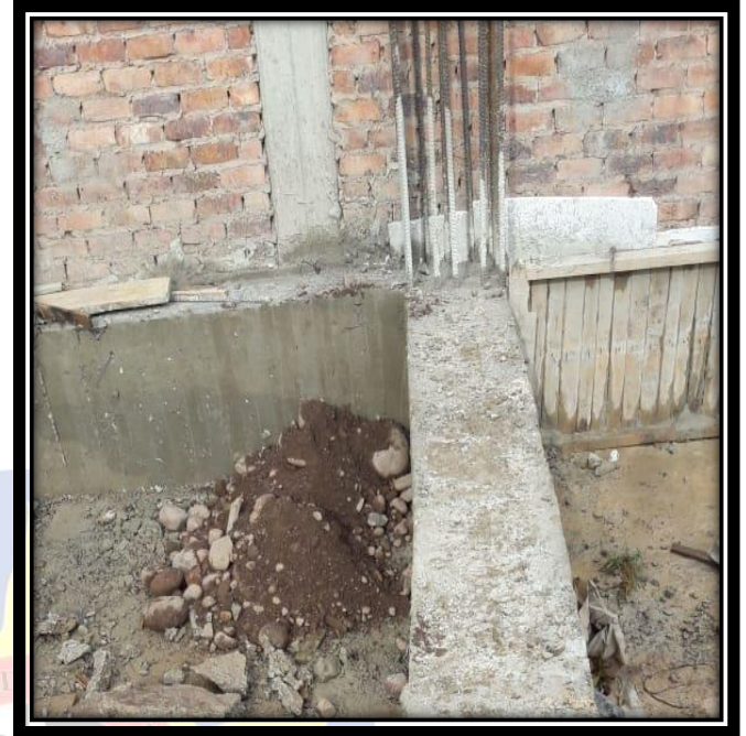
Ilustración 31: Viga de Cimentación Tipo (C) Concreto
