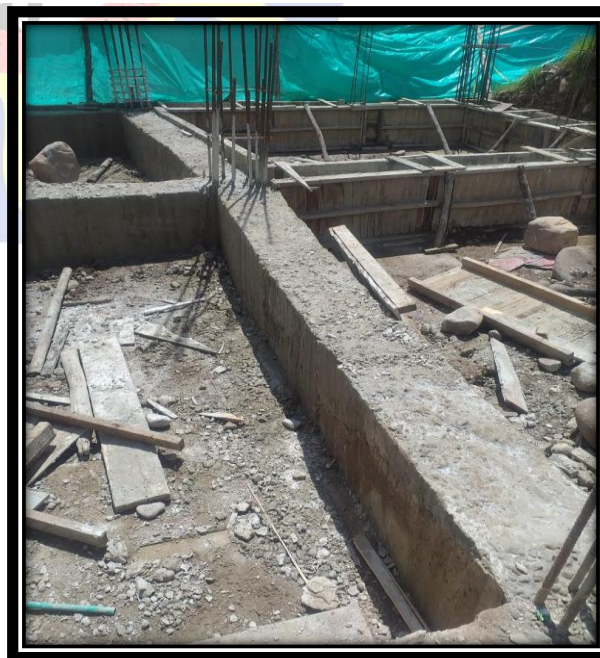
Ilustración 46:Viga de Cimentación Tipo (4) Concreto-2
