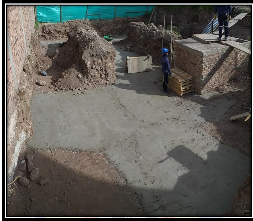
Ilustración 13: Solados De La Cimentación
