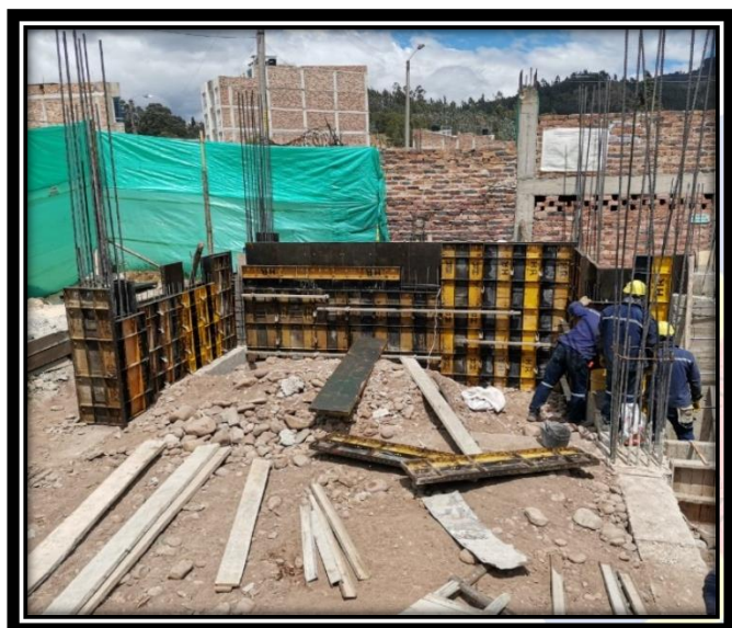
Ilustración 52: Muro de Contención
