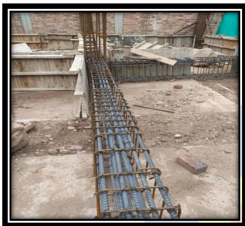
Ilustración 45:Viga de Cimentación Tipo (4)
