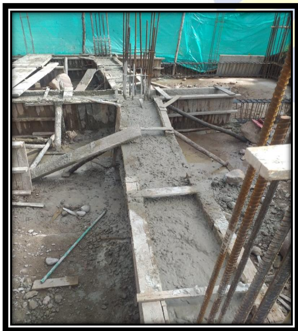
Ilustración 47:Viga de Cimentación Tipo (4) Concreto
