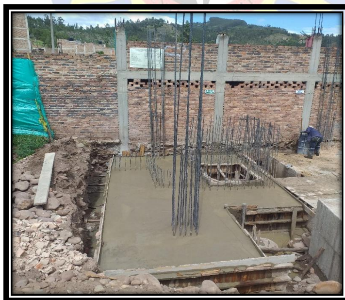
Ilustración 22: Zapata Continua Tipo (3) Concreto
