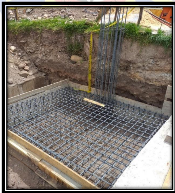
Ilustración 19: Zapata Medianera Tipo (2)
