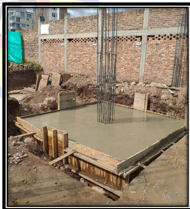
Ilustración 16: Zapata Aislada tipo (4) Concreto
