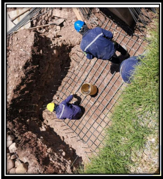
Ilustración 24: Zapata Medianera Tipo (2)
