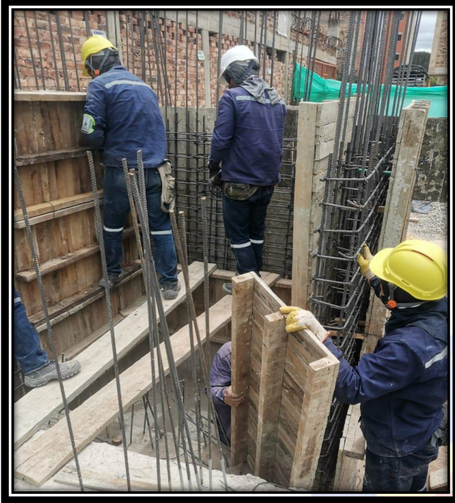
Ilustración 55: Pantalla de Ascensor Encofrada
