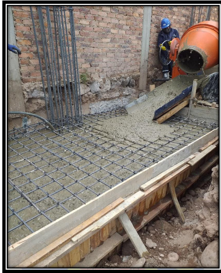
Ilustración 18: Zapata Medianera Tipo (5)
