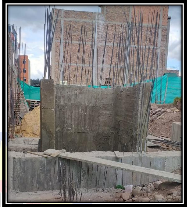
Ilustración 54: Pantalla de Ascensor Colocada
