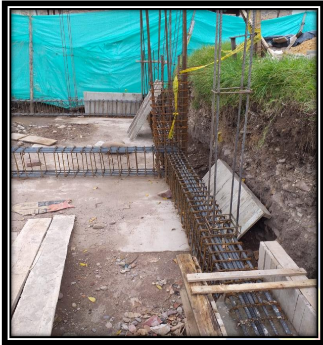
Ilustración 48:Viga de Cimentación Tipo (5)
