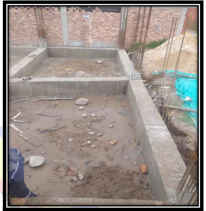
Ilustración 49:Viga de Cimentación Tipo (5) Concreto
