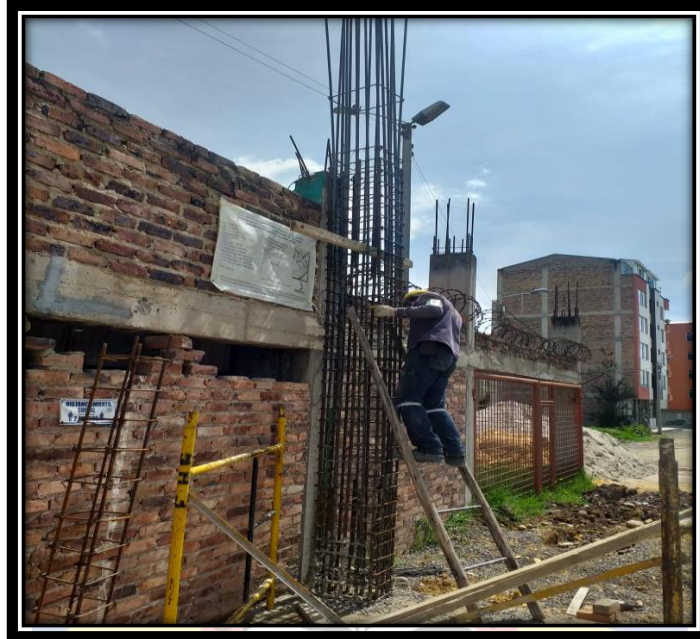
Ilustración 60:Columna Tipo (C) 5 - Acero
