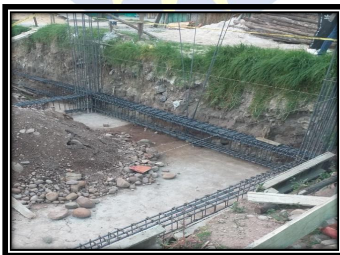
Ilustración 25:Viga de Cimentación Tipo (A) 1-2
