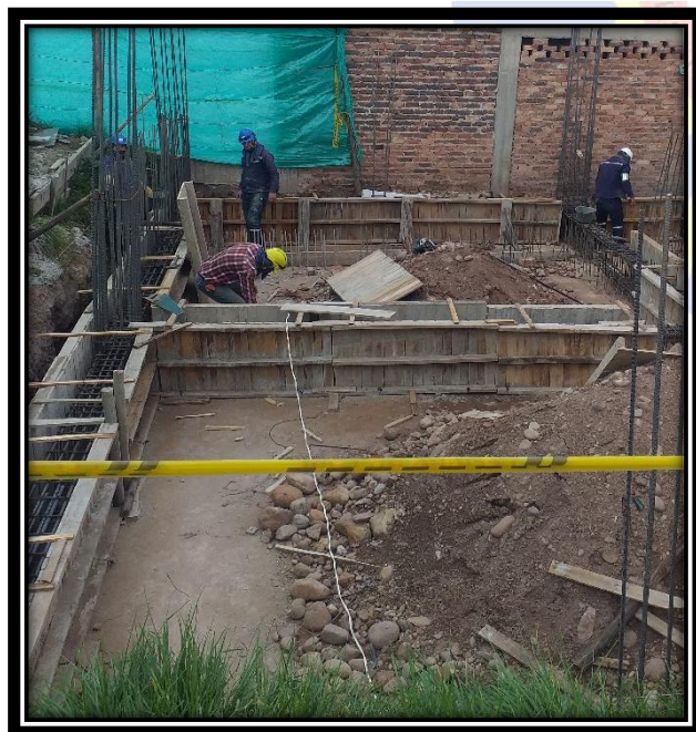
Ilustración 35:Viga de Cimentación Tipo (1) -3
