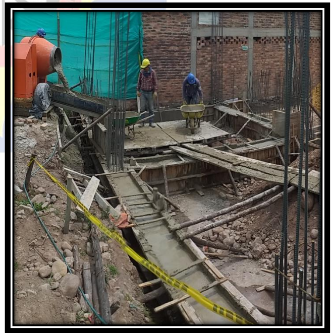
Ilustración 36:Viga de Cimentación Tipo (1) Concreto
