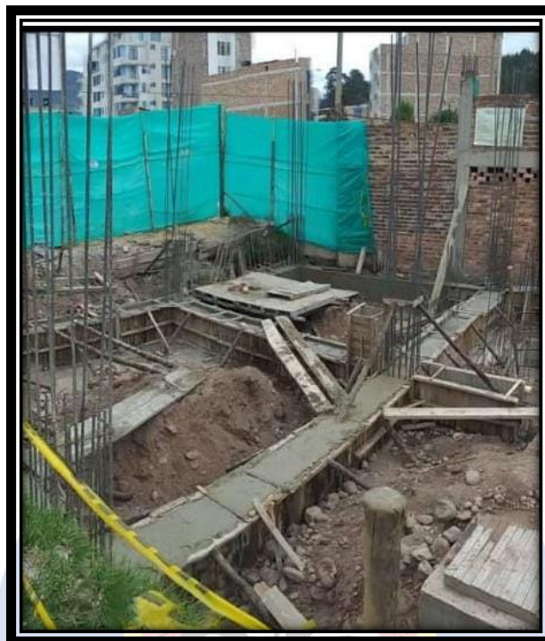
Ilustración 39: Viga de Cimentación Tipo (2) Concreto
