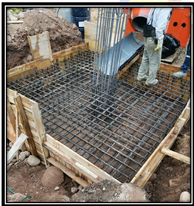
Ilustración 17: Zapata Aislada tipo (4) Acero
