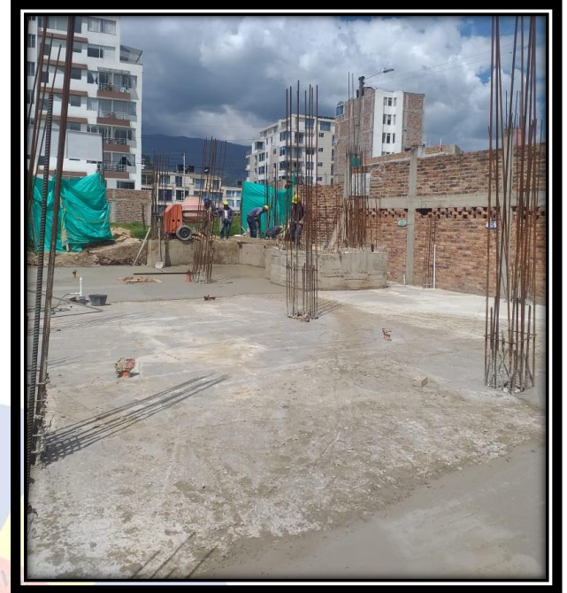
Ilustración 58: Loseta Antepiso Colocada
