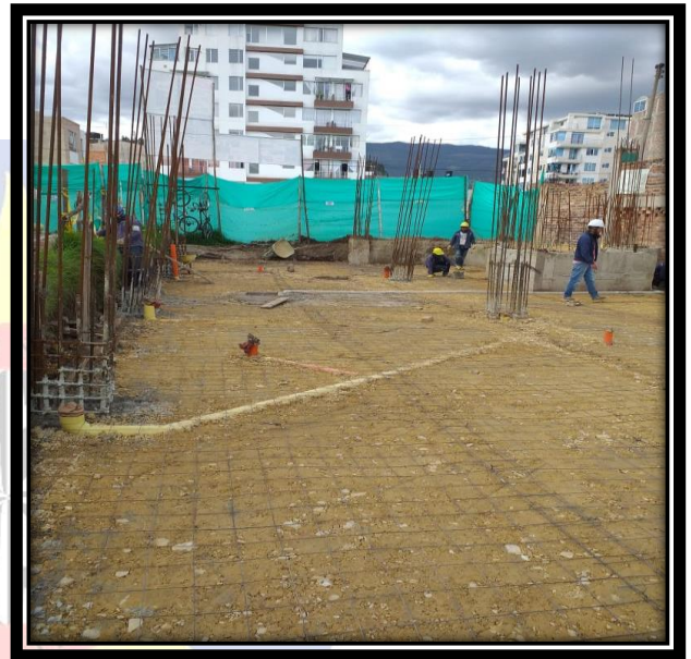
Ilustración 56:Malla Electrosoldada de Loseta
