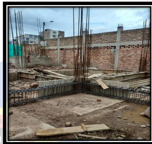
Ilustración 44:Viga de Cimentación Tipo (4)-2
