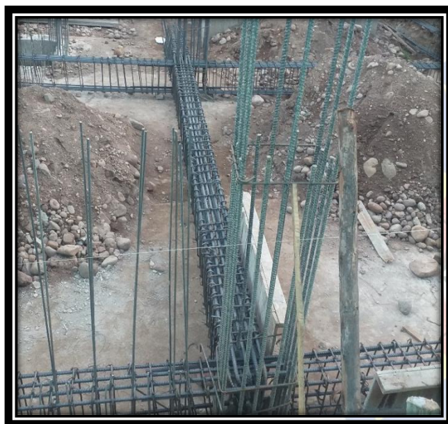
Ilustración 30:Viga de Cimentación Tipo (B) 1-2
