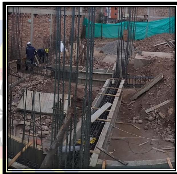
Ilustración 29:Viga de Cimentación Tipo (B)
