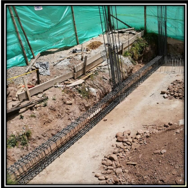
Ilustración 34:Viga de Cimentación Tipo (1) Acero
