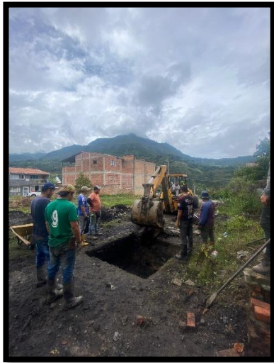
Ilustración 8. Proceso de construcción de zapatas.
