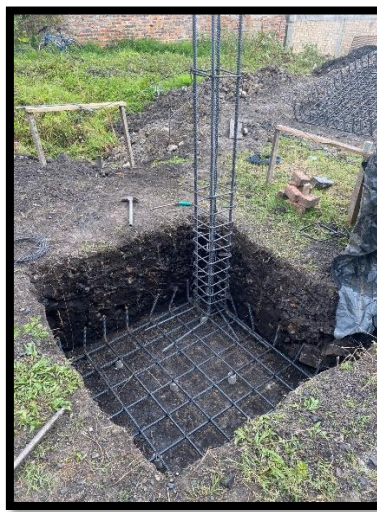
Ilustración 8. Proceso de construcción de zapatas.
