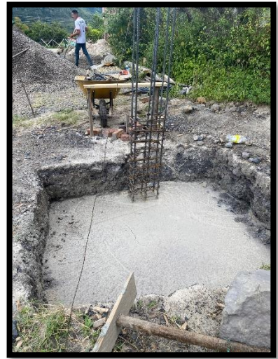
Ilustración 8. Proceso de construcción de zapatas.
