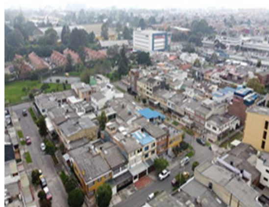
Vista área del sector hacia la Av. 68
