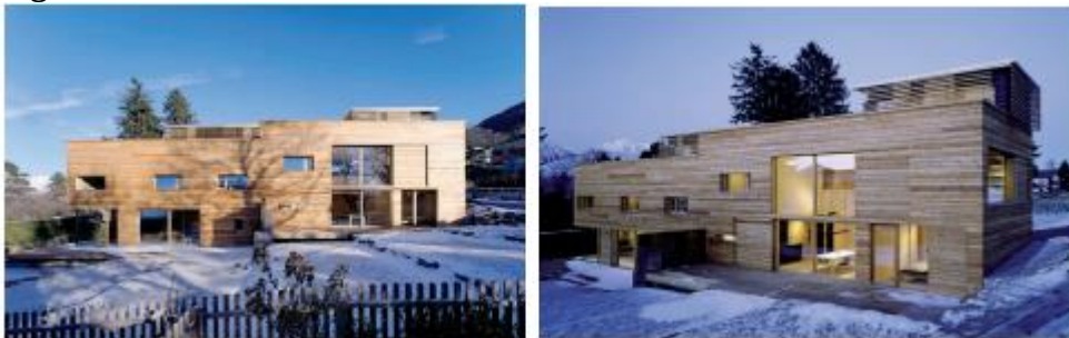
Figura 6. Obras realizadas en madera
