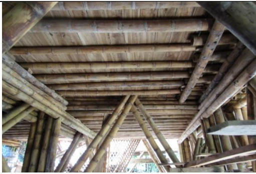
Entrepiso en guadua y madera nogal.
