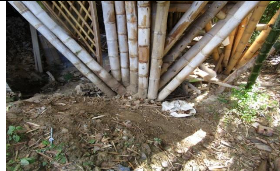
Sección compuesta de columna
