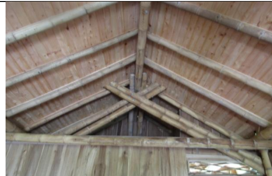
Techo de la estructura con tablilla de pino.
