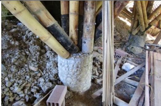
Pedestales de apoyo como cimentación
