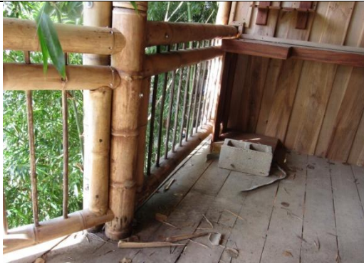
Estructura de los pasamanos, en guadua y macana.
