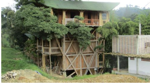
Foto de fachada lateral del paciente (Edificio en guadua).
