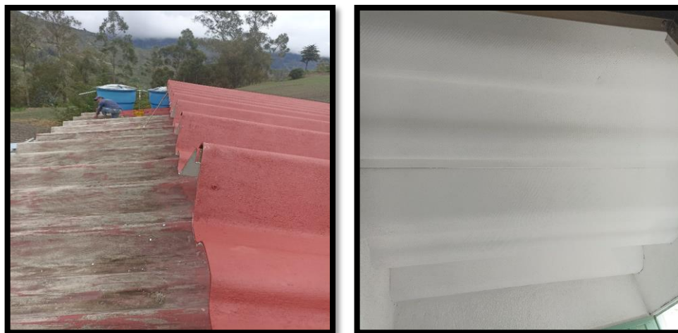
Figura 8: Limpieza y pintura de cubierta externa e interna.
