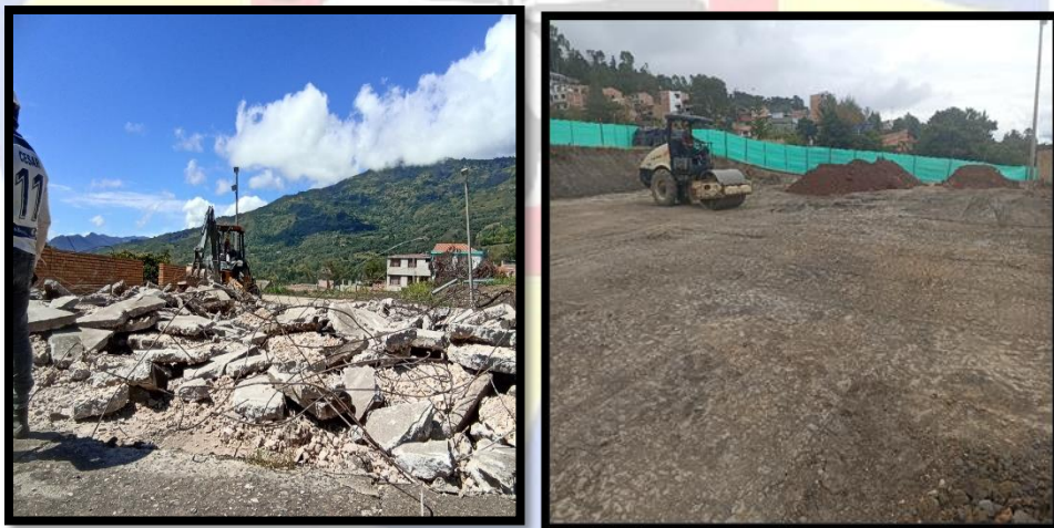
Figura 18: Demolición de placa y compactación del terreno.
