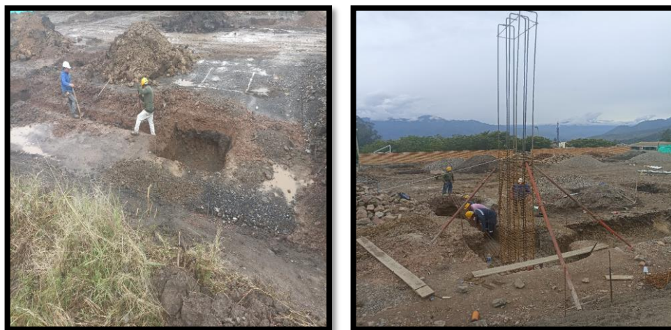
Figura 20: Excavación, figurado, amarre y fundición de solado de vigas de amarre.
