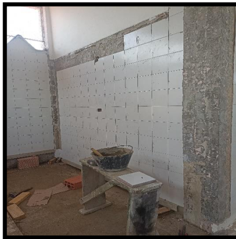
Figura 7: Suministro e instalación de enchape para muros y pisos.
