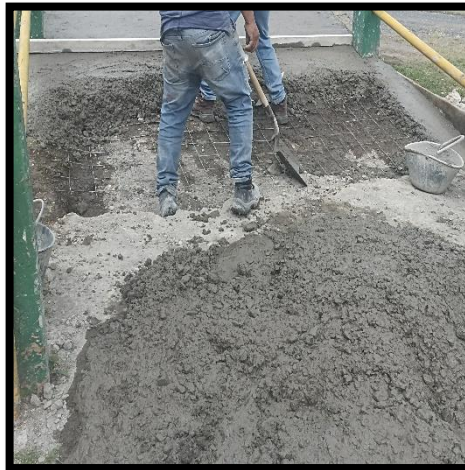
Figura 6: Fundición de losa maciza.
