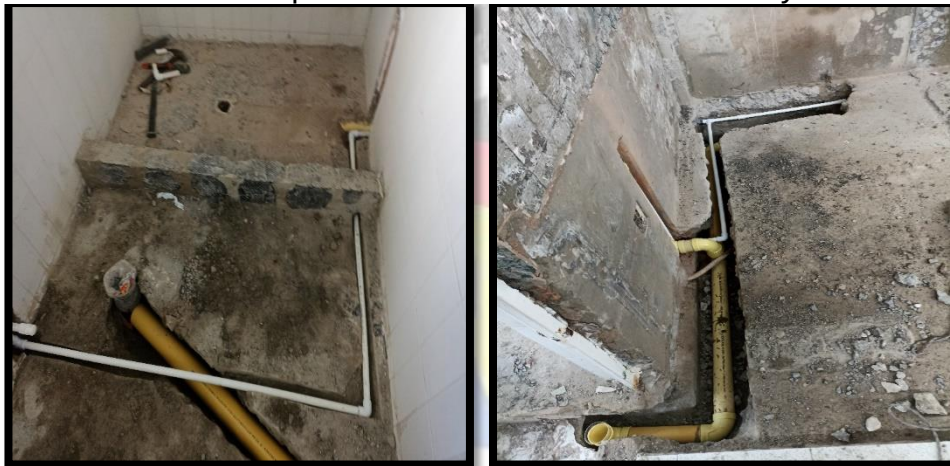
Figura 2: Instalación de puntos hidráulicos con accesorios y tubería PVC sanitaria
