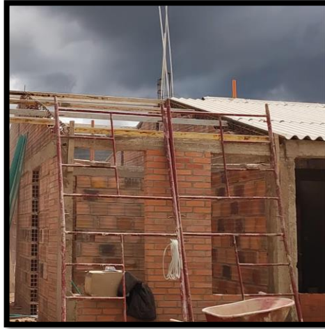
Figura 16: Instalación de perfil y cubierta.
