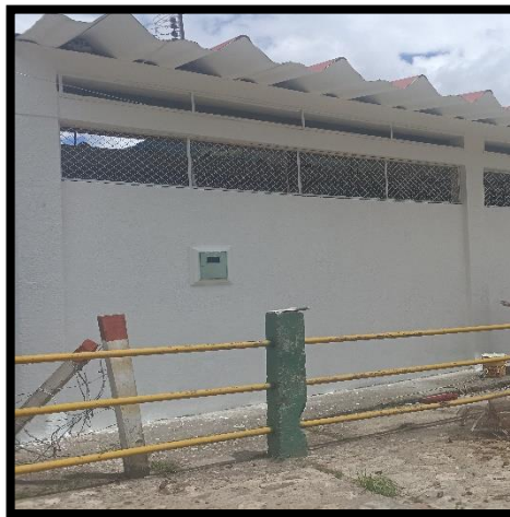
Figura 9: Pintura parte interna y externa de la planta.
