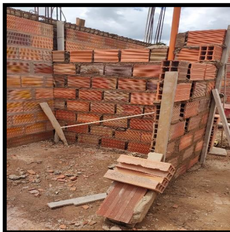
Figura 13: Mampostería muros internos y externos.
