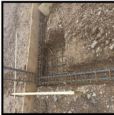
Figura 11: Excavación manual para ubicación de zapatas.
