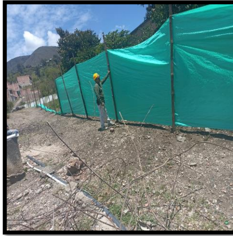
Figura 17: Marcación y excavación para cerramiento perimetral.
