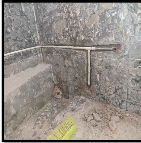
Figura 3: Desmonte de angeo.
