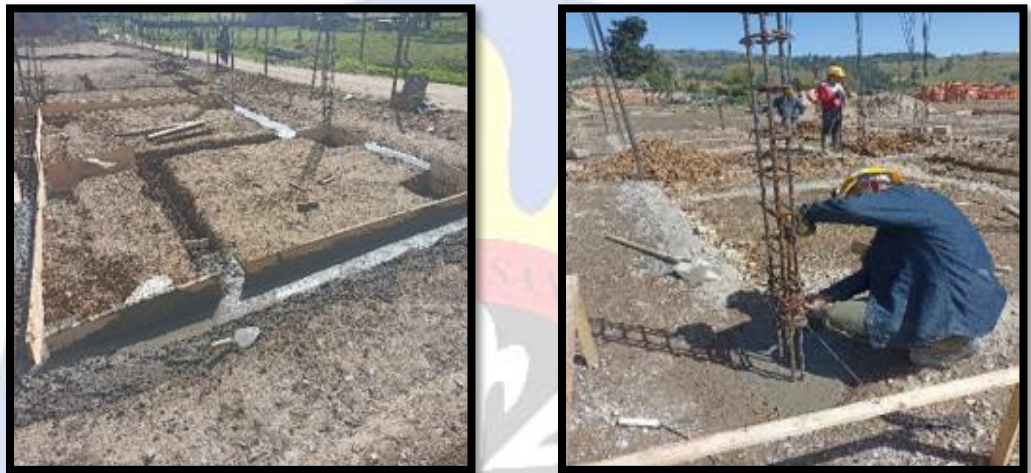
Figura 12: Figurado, encofrado y fundida de las vigas de cimentación.
