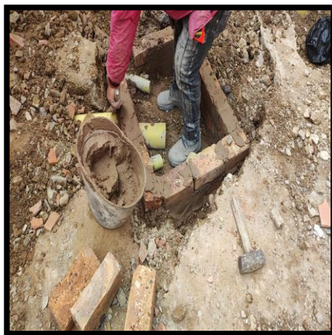
Figura 14: Construcción de caja de inspección.
