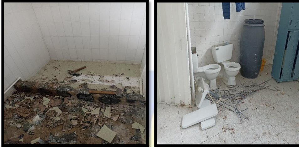
Figura 1: Demolición muros, pisos y desmonte de unidades sanitarias y baños.
