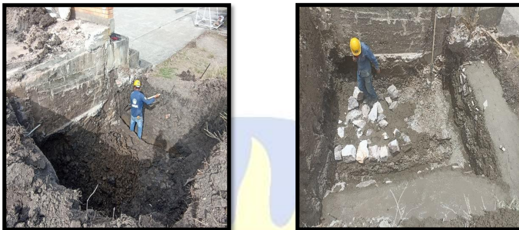
Figura 19: Excavación, figurado y amarre de vigas para muro de contención.
