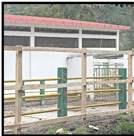
Figura 10: Instalación de cerramiento perimetral.
