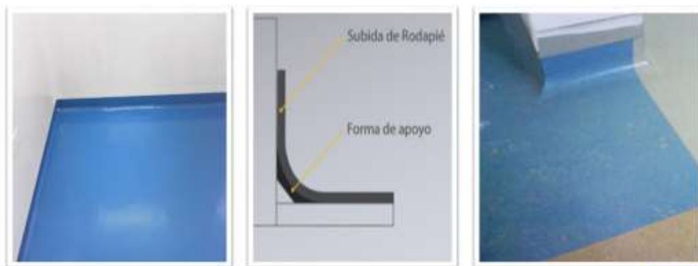
Figura 22: Adecuación pisos y paredes
