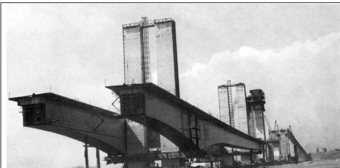
Vigas Cajón Prefabricadas (Vano central)
