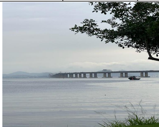
Vista puente Costa e Silva (Rio-Niteroi) desde UFRJ
