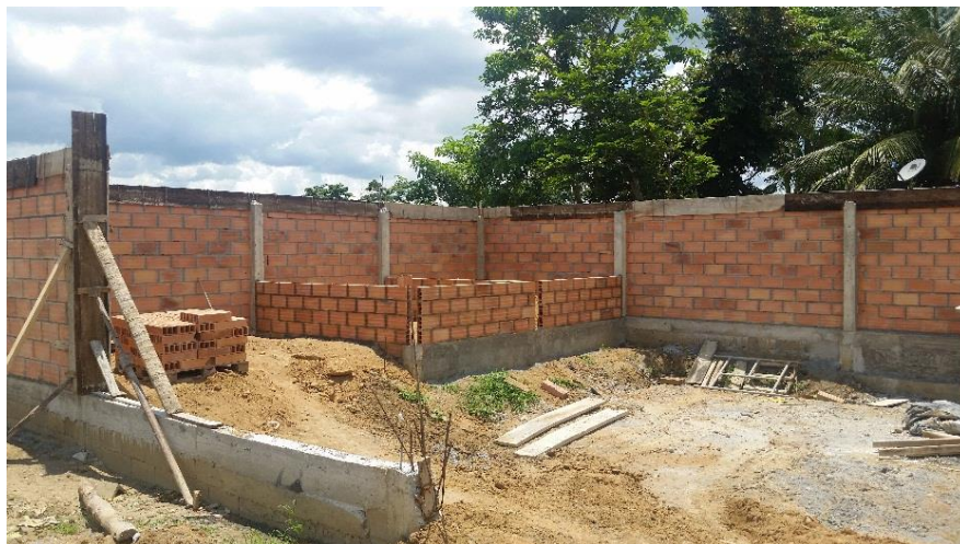
Imagen 5 Cerramiento y caseta de lecho de secado de lodos
