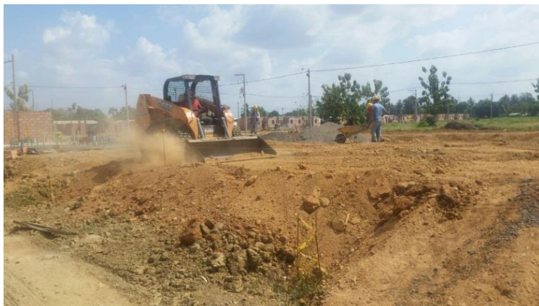
Imagen 6 Conformación de las terrazas con material seleccionado (Balasto)
