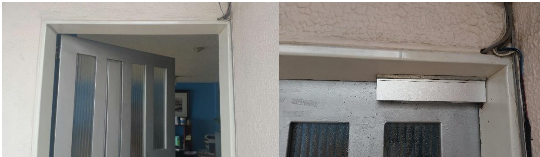
Figura 30. Adecuación del marco de la puerta para la instalación de la cerradura electromagnética Fuente: Autor
