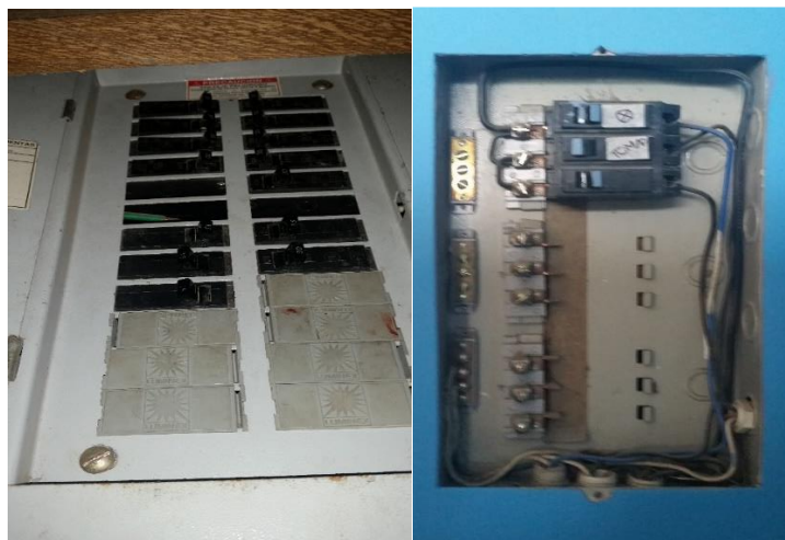
Figura 19. Caja de distribución (a) principal de energía eléctrica, (b) sectorizada para la segunda planta Fuente: Autor
