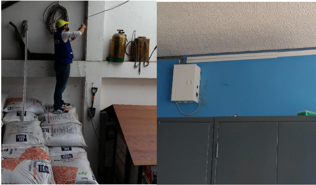
Figura 26. Extensión del cable desde la primera planta para su conexión en la caja de control Fuente: Autor
