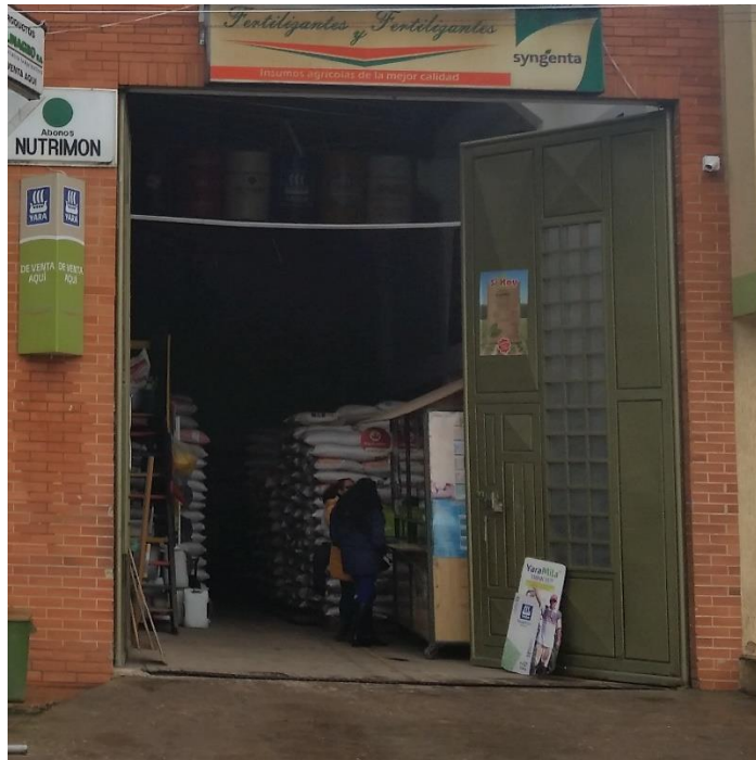
Figura 29. Portones industriales de lámina de acero, que conforman la entrada principal al almacén de insumos agrícolas Fuente: Autor
