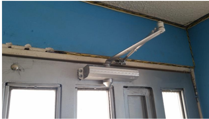
Figura 31. Instalación del brazo hidráulico como mecanismo de disminución de la fuerza de impacto Fuente: Autor
