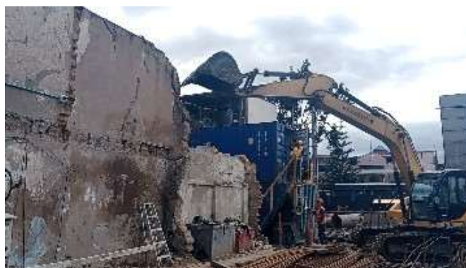
Ilustración 24. Evidencia demolición de muros Caso A.
