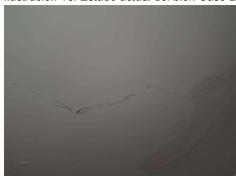
Ilustración 13. Estado actual del bien Caso B.
