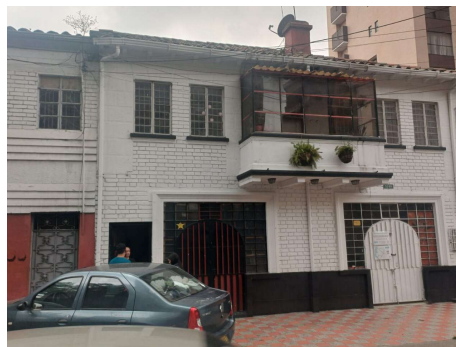
Ilustración 11. Estado actual del bien Caso B.
