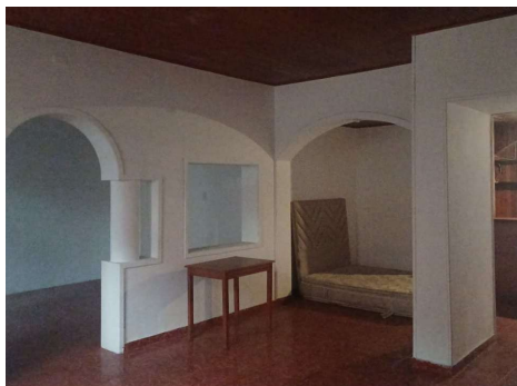
Ilustración 10. Estado actual del bien Caso B.
