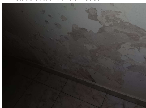
Ilustración 12. Estado actual del bien Caso B.
