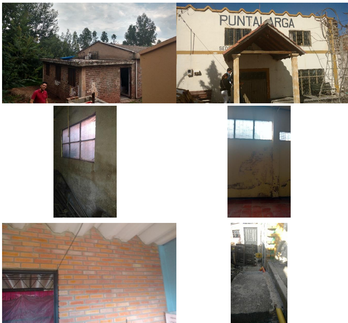
Fotografía 10. Inspección Salones comunales de las Veredas Puntalarga, San Martín y Dichó.
