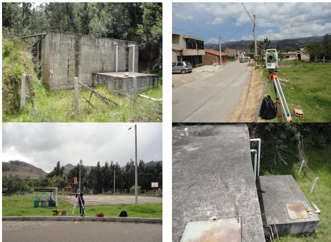
Fotografía 9. Levantamiento topográfico vía Chámeza sector alto.
