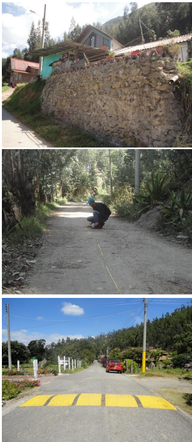
Fotografía 3. Inspección visual y levantamiento de medidas en la Vía Rincón de las Campanas.
