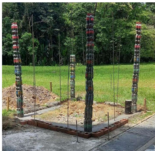
Figura 17. Conformación de columnas por botellas PET
