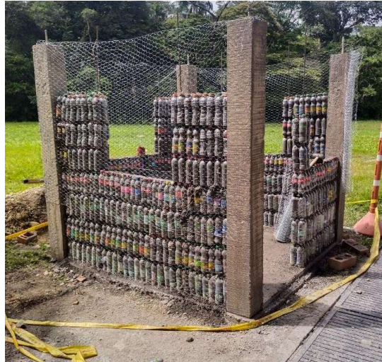
Figura 19. Conformación de muros con botellas PET
