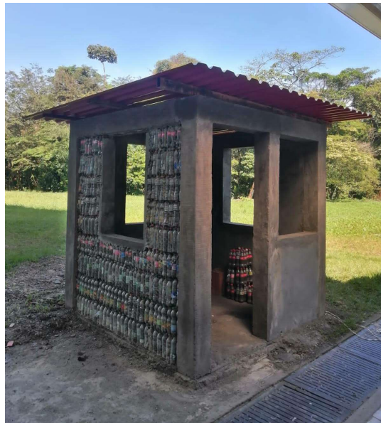
Figura 21. Instalación de cubierta de estructura Fuente: Autor.
