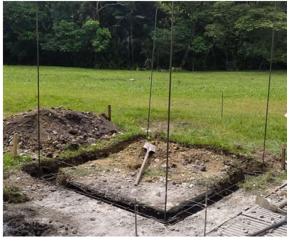
Figura 15. Conformación de vigas de cimentación Fuente: Autor.
