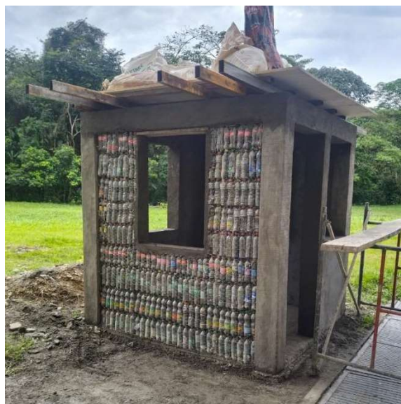
Figura 24. Aplicación de cargas verticales en plataforma sobre la estructura. Fuente: Autor.
