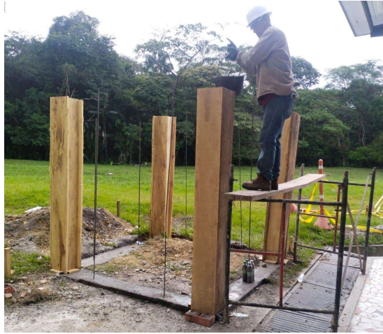
Figura 18. Vaciado de concreto en formaletas para columnas
