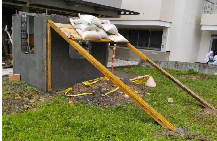
Figura 22. Plataforma de transmisión de cargas laterales Fuente: Autor.
