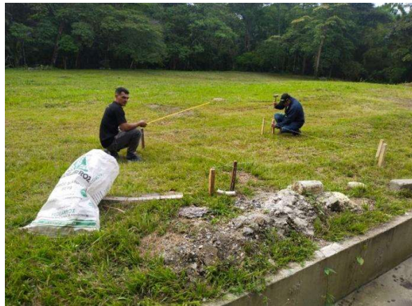
Figura 14. Replanteo de la obra Fuente: Autor.
