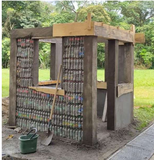
Figura 20. Vaciado de vigas aéreas Fuente: Autor.
