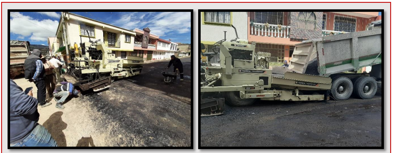
Figura 14: Instancian de carpeta asfáltica.
