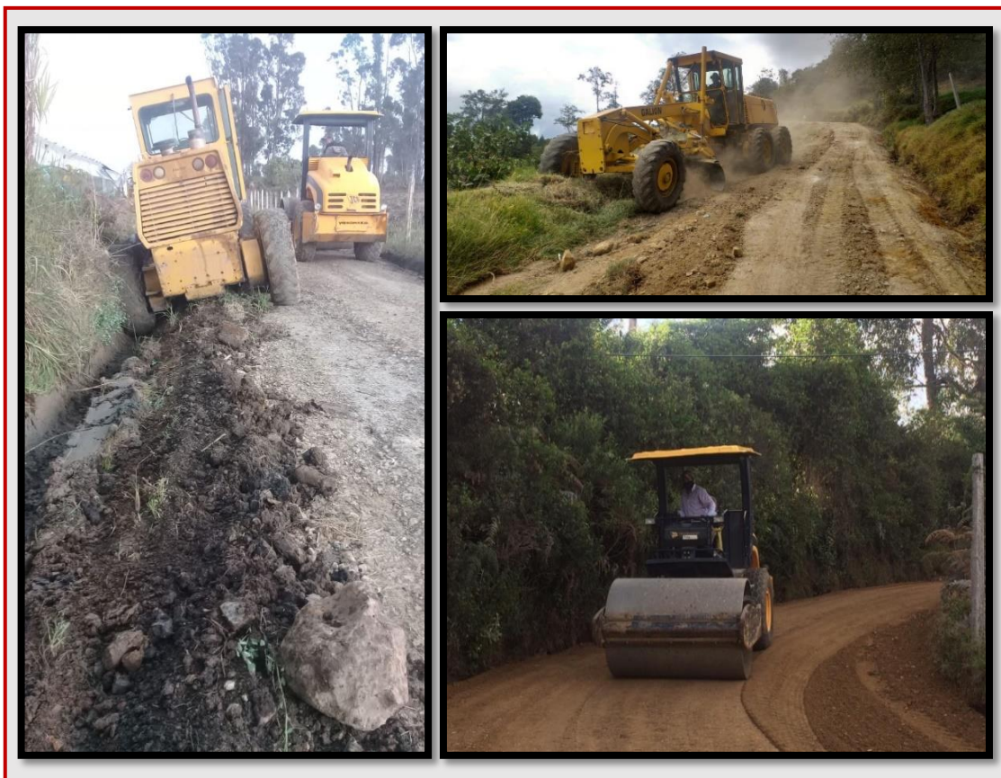
Figura 19: Perfilado, Cuneteo y Compactado (veredas centro, pedregal bajo, santo eccehomo).
