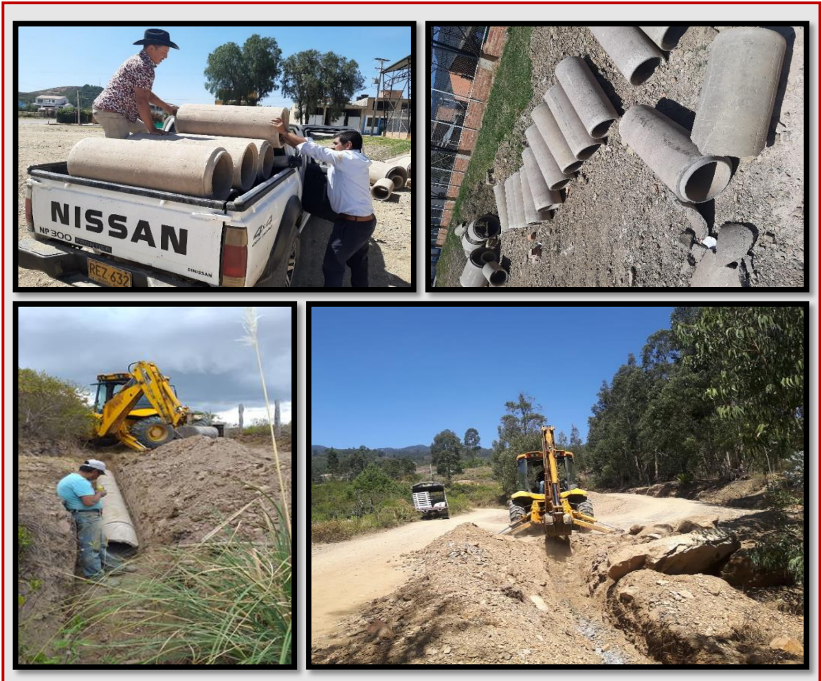
Figura 18: Entrega e instalación de tubería en concreto.
