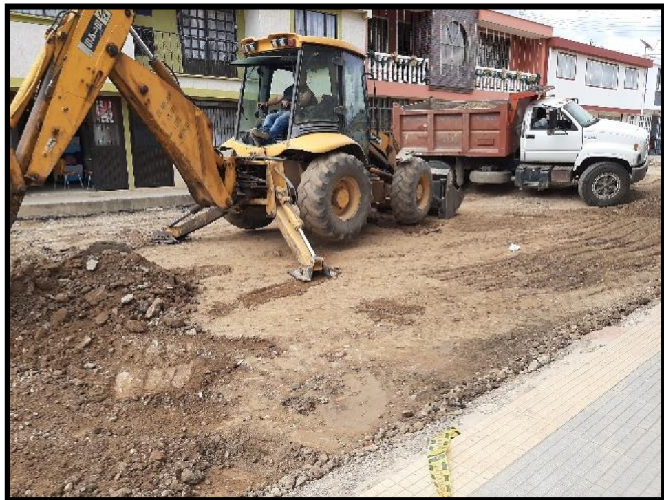
Figura 9: Preparación del material de subrasante.
