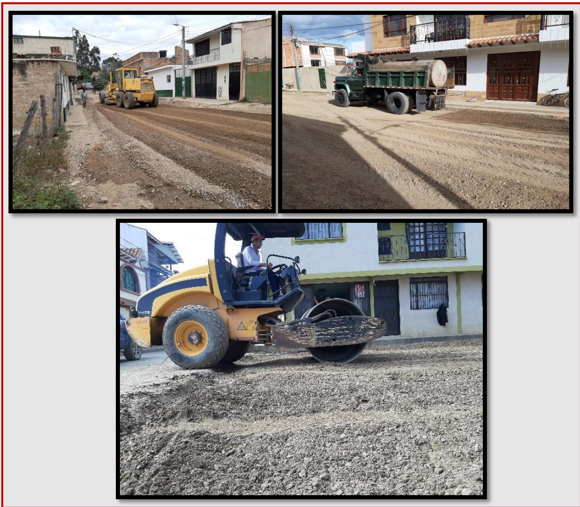
Figura 11: Preparación de la sub base granular.
