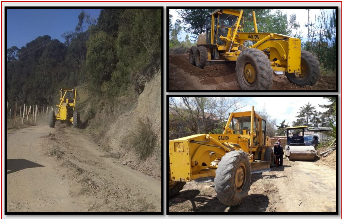
Figura 20: Perfilado, cuneteo y compactado (veredas Cañón, Volcán, Esperanza).
