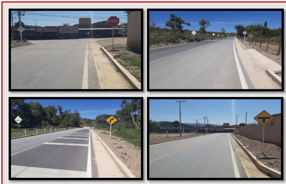
Figura 25: Demarcación de la vía.
