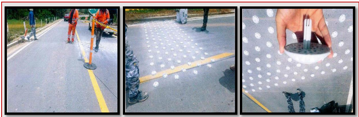
Figura 26: Instalación de reductores de velocidad.
