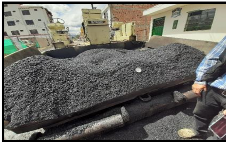
Figura 16: Verificación de la temperatura de la mezcla en caliente al momento de la descarga en Finisher.
