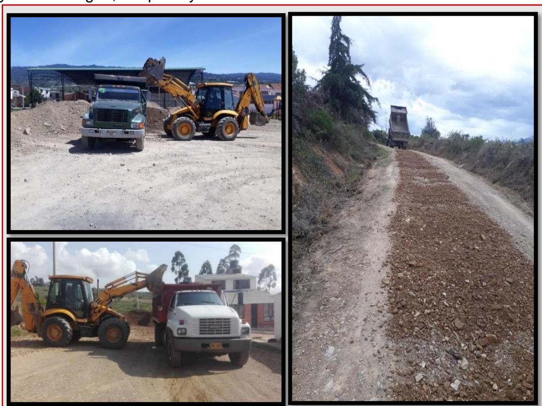
Figura 21: Cargue, trasporte y extendido de afirmado.
