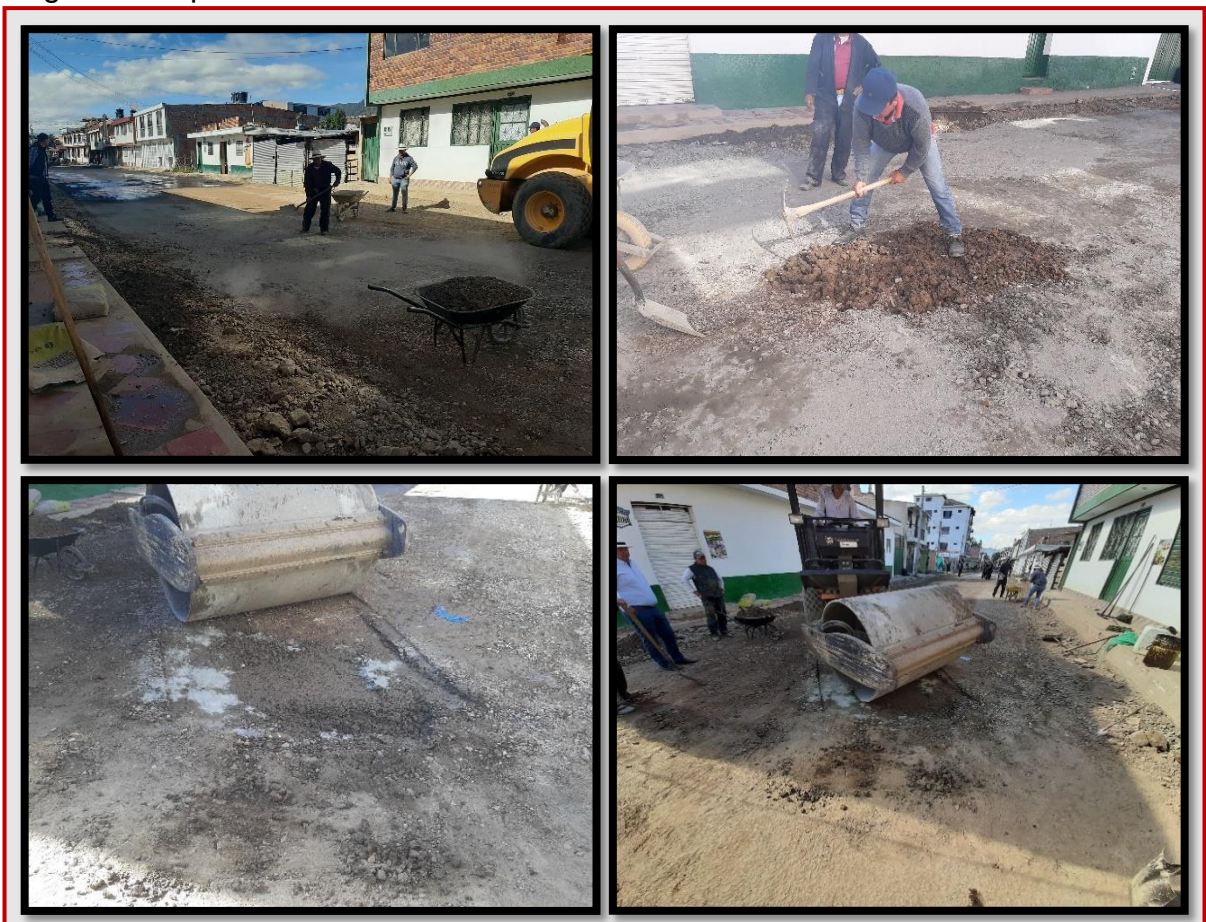
Figura 12: Aplicación de cemento en la zona de humedad.
