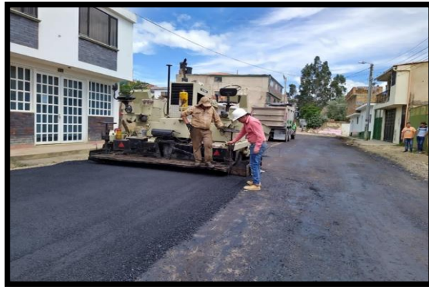
Figura 15: Verificación del espesor de la capa.
