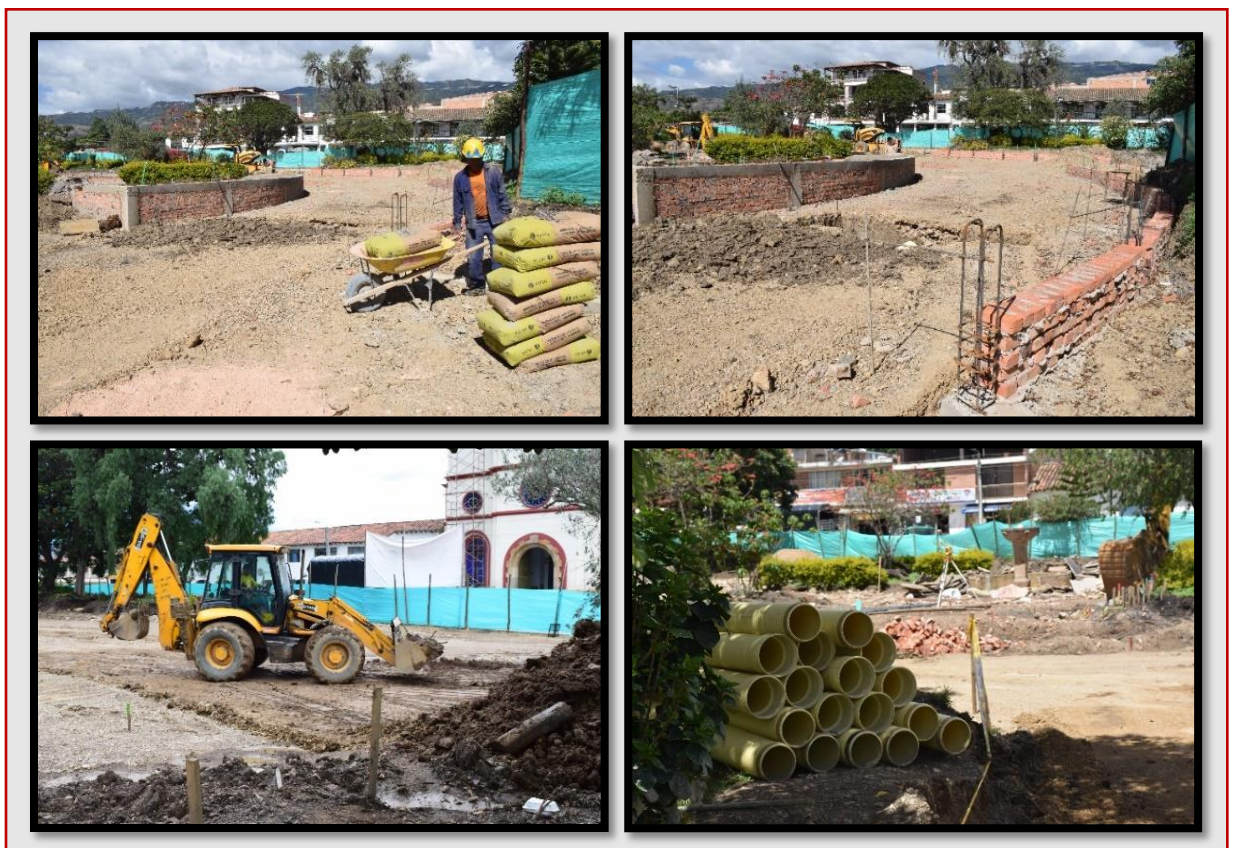
Figura 27: Seguimiento a obra (mejoramiento parque principal).
