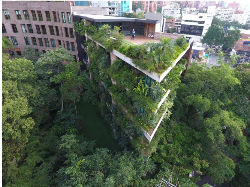
Figura 10. Fachadas Edificio el Matorral
