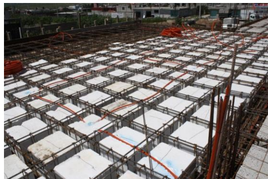
Figura 75. Losa aligerada con casetones de poliestireno (EPS)
