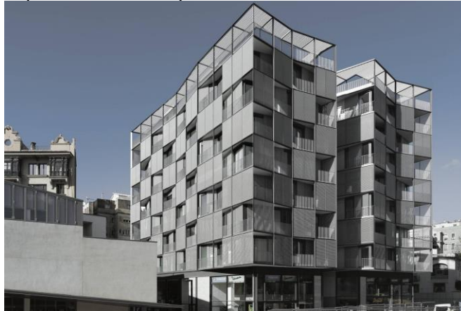
Figura 14. Fachadas Edificio Plaza Lesseps
