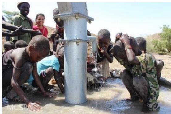
Acción 3: Perforación de pozos con instalación de bomba manual
