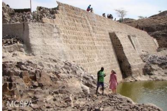
Acción 1: Construcción de presas de roca
