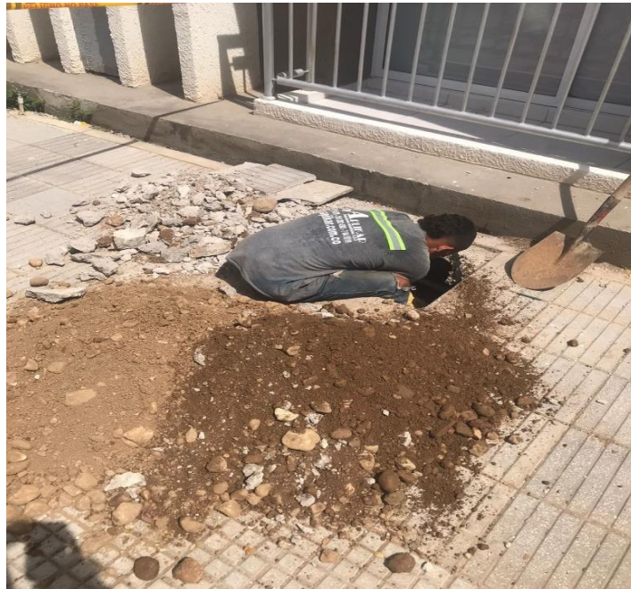
Figura 19. Evidencia fotográfica avances de obra
