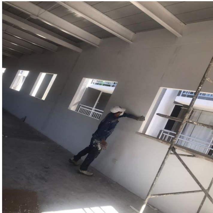
Figura 20. Evidencia fotográfica avances de obra
