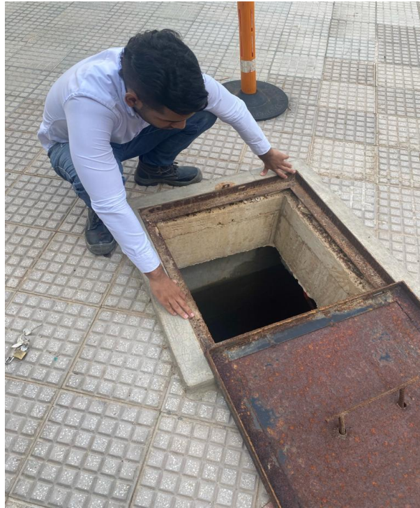
Figura 22. Registro fotográfico supervisión limpieza tanques subterráneos
